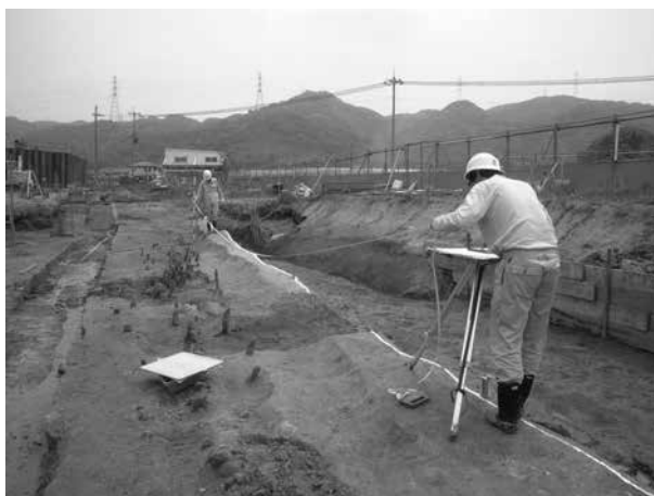
写真4 現地調査 測量作業状況
