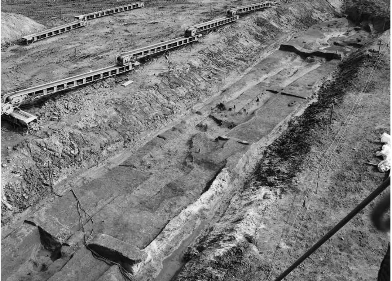
1.3-1区 中世遺構面全景（西から）
