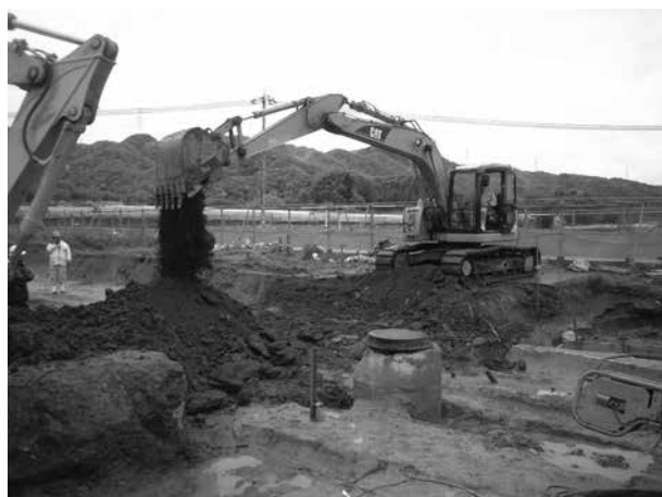
写真1 現地調査 機械掘削状況
