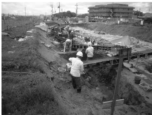
写真2 現地調査 人力掘削状況
