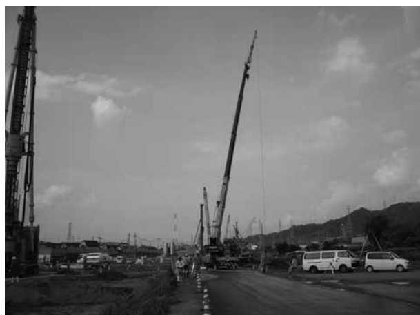
写真3 写真測量 実施状況
