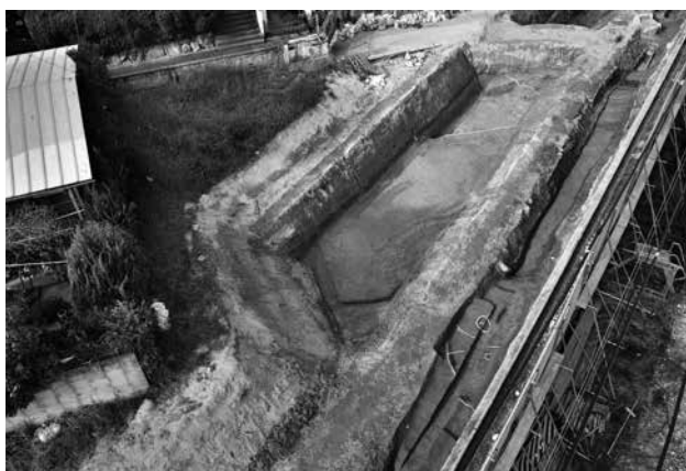
4. 2-1区中央部 古墳時代後期～中世遺構面全景（南から）
