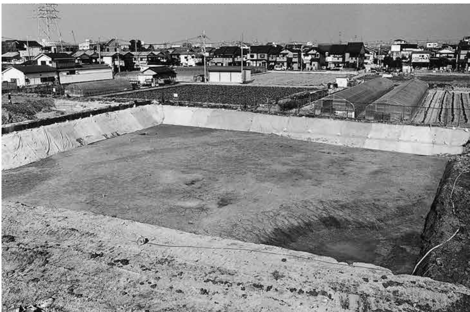
2. 5-3区西 第11面 (南から)
