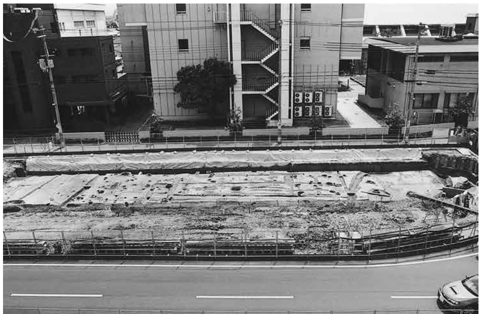
2. 2区 第3面 西半 (北から)
