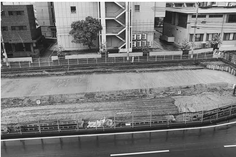
2. 2区 第1面 西半 (北から)
