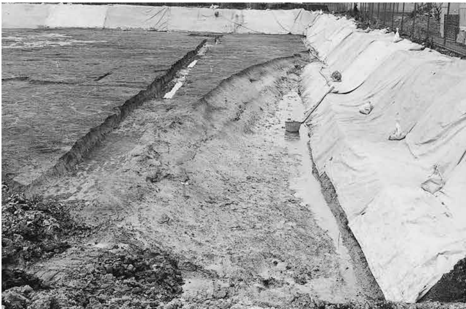
2. 5-3区西 第8面 4003流路 (東から)
