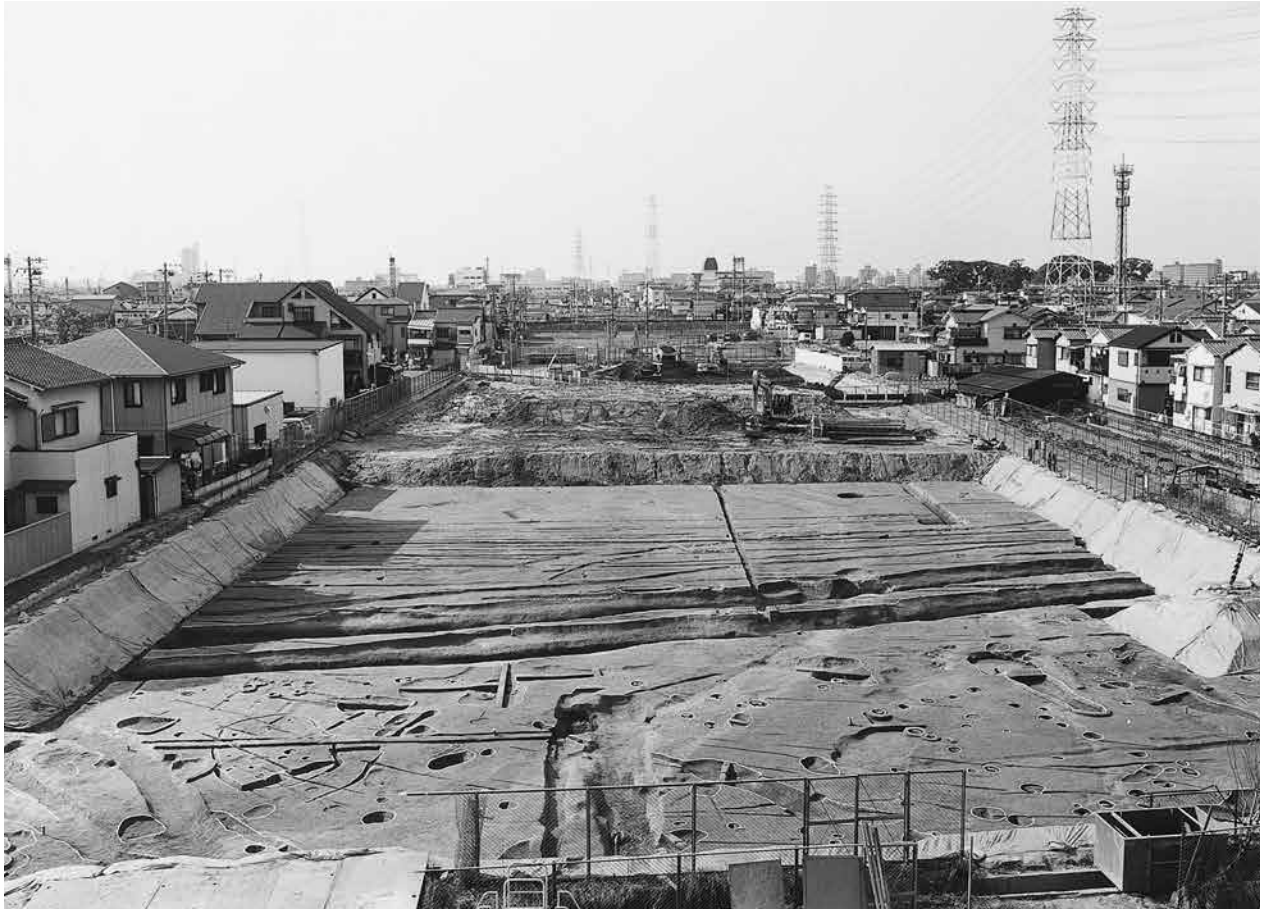
1. 3-2区 第4面 (東から)
