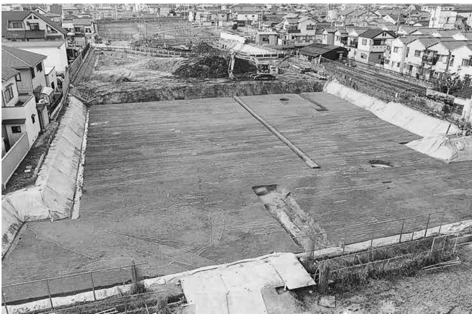
2. 3-2区 第2面 (東から)
