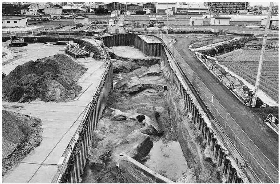
2. 3区 第3面 南半 (北から)
