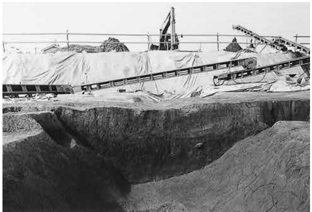
5. 5-2区 第4面 1766溝 南側断面 (南から)
