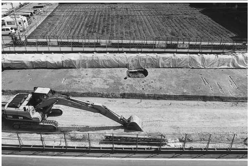
3. 2区 第2面 東半 (北から)
