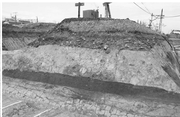
8. 第8地区 南東張り出し部壁
