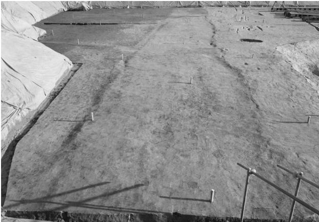
2. 第5面 東部 全景 (北西から)
