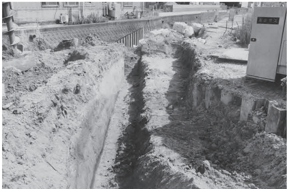
2.5区 第1面 23水路（北西から）
