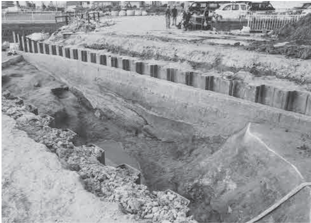
1. 3区 第2面 3流路 断面 (南西から)
