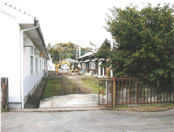
調査後の掘削
