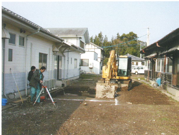
調査後の掘削
