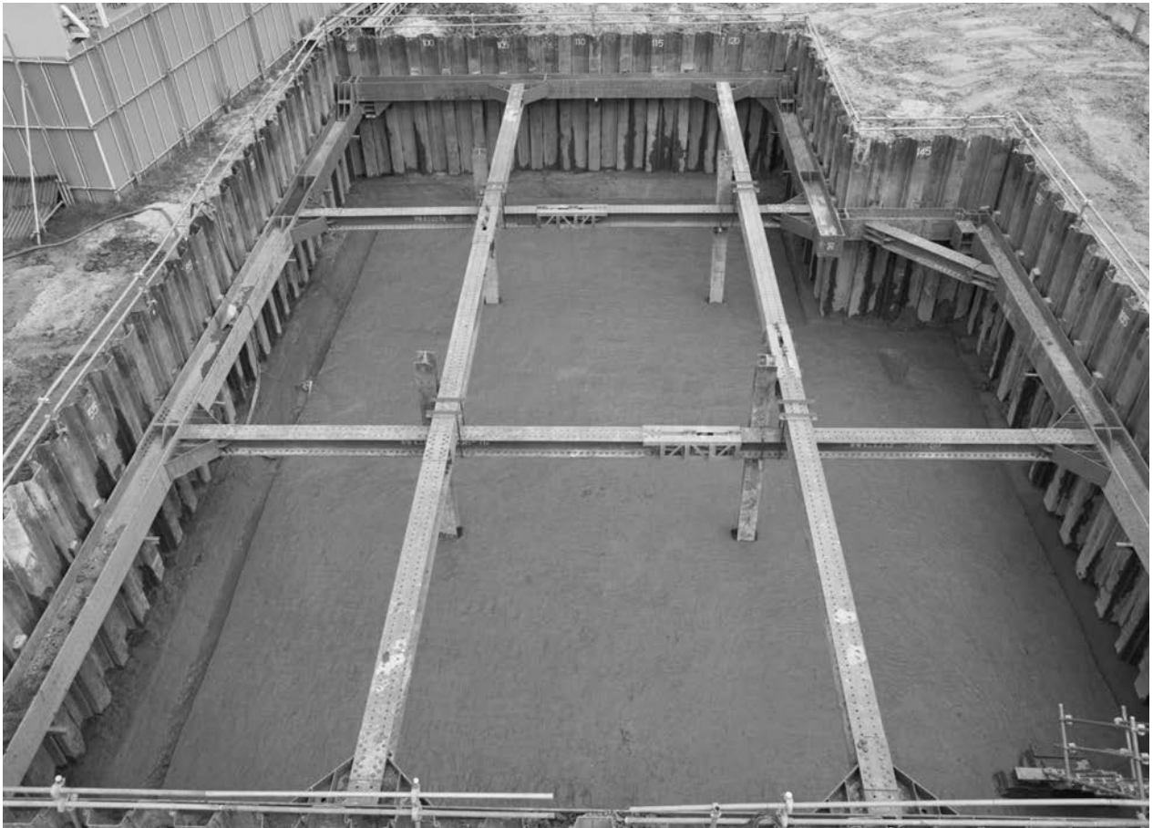
1. 08-1-2-2区 第8-3遺構面全景(西から)
