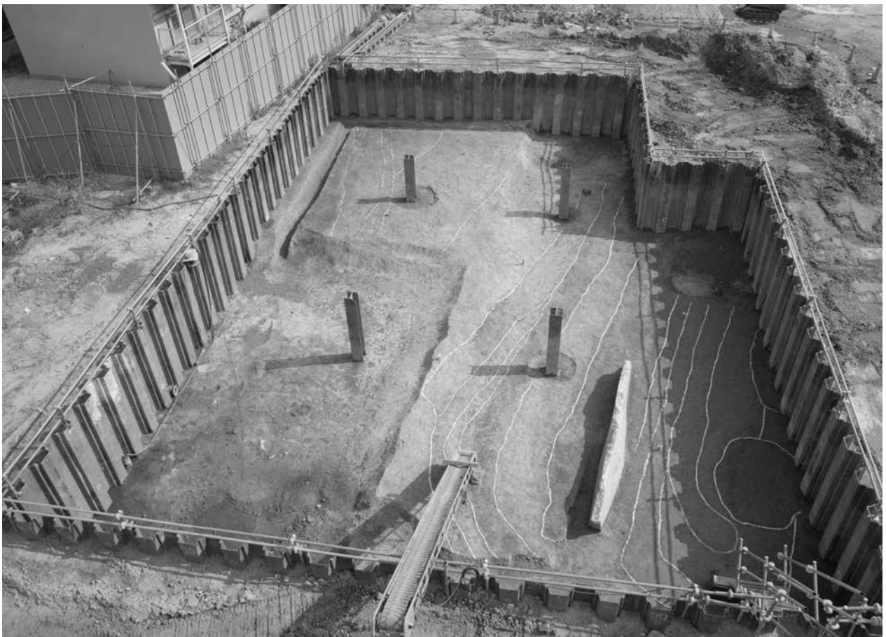
2. 08-1-2-2区 第5遺構面全景(西から)
