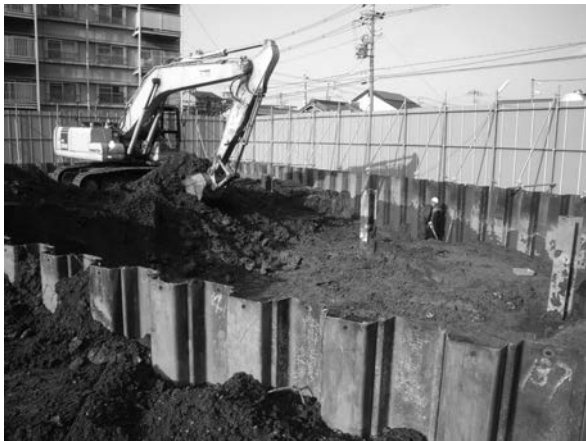
1-1 重機掘削作業状況
