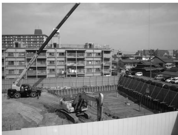
2-1 写真測量実施状況
