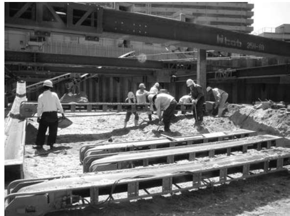
1-2 人力掘削作業状況
