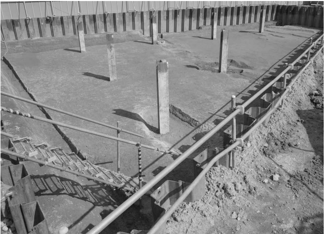
2. 08-1-1区 第3・第4遺構面全景(北西から)
