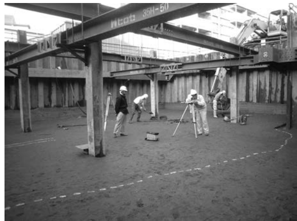
1-4 平面測量作業状況
