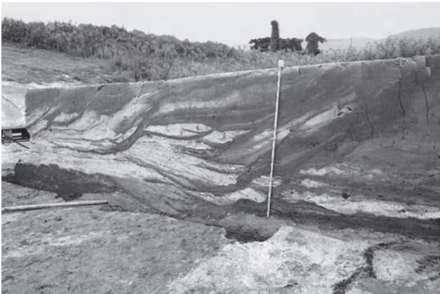
2. 1224 流路断面 (南西から)
