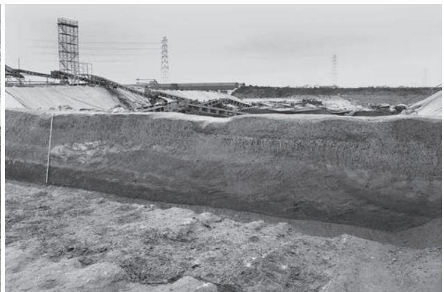
5. 第2-1 a層上面~第3-4 a層上面島断面 (2区、南から)
