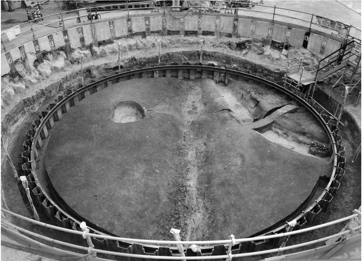
第4 a - 1面盛土上層除去状況
