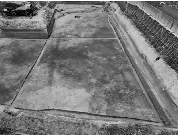
3. 第4面 (11-1区東半:北から)
