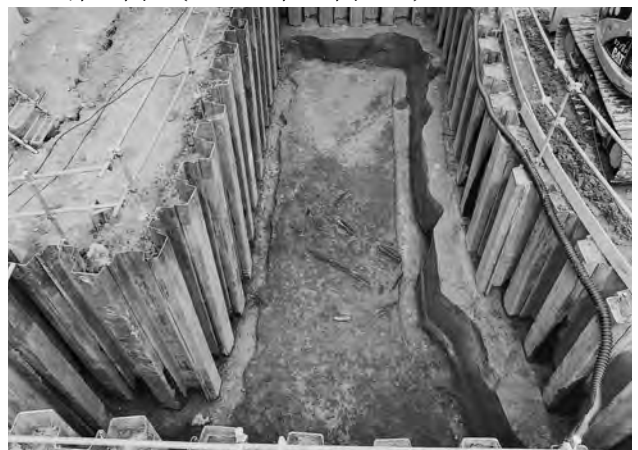
8. 第4面 (9-3区:西から)
