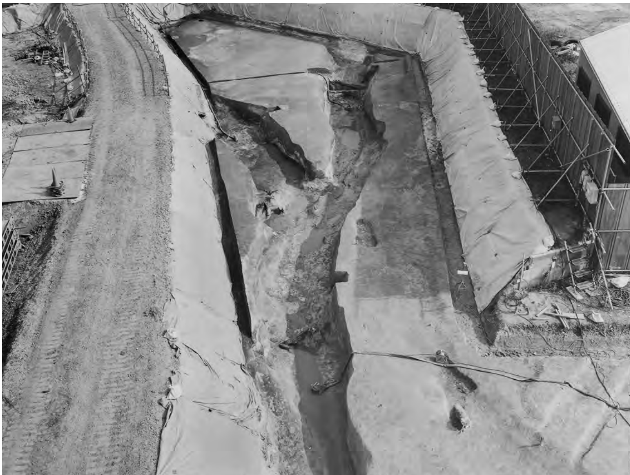
5. 第5-1面 (1区: 西から)
