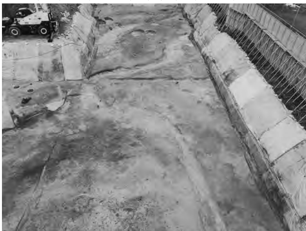
5. 第6面 (11-1区東半: 北から)
