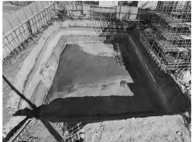
6. 第4面 (24-1区:西から)
