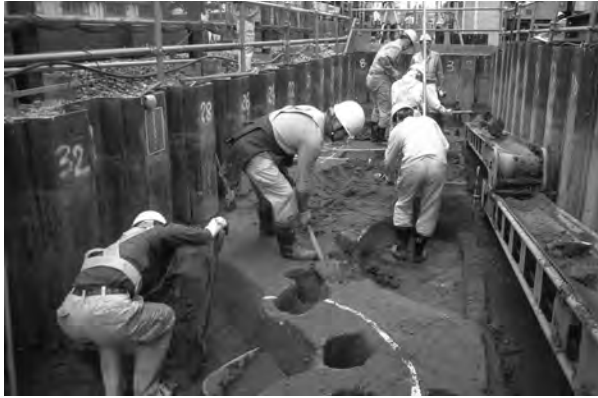
写真2 人力掘削作業
