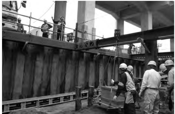
写真 22 銭貨埋納遺構 木枠の吊り上げ移動
