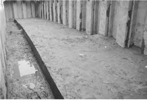
1. 10-1-3区 第6遺構面 全景(北西から)
