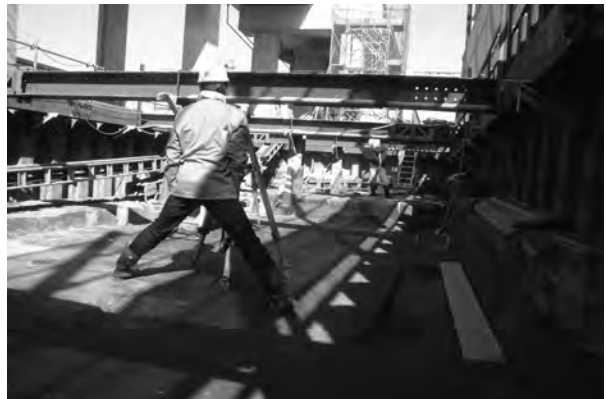
写真8 レベル測量作業
