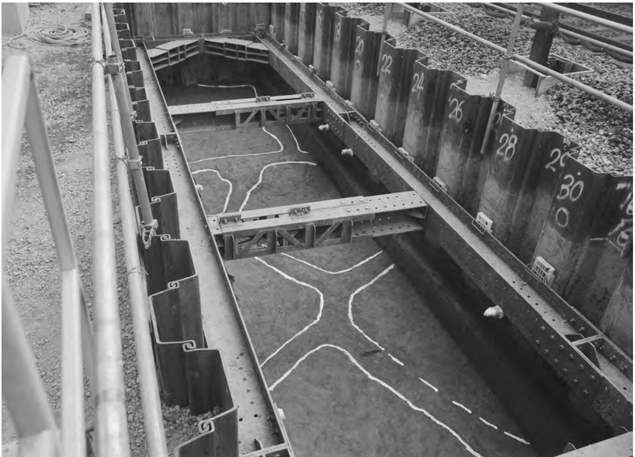
5. 10-1-6区 第10遺構面 全景(北西から)
