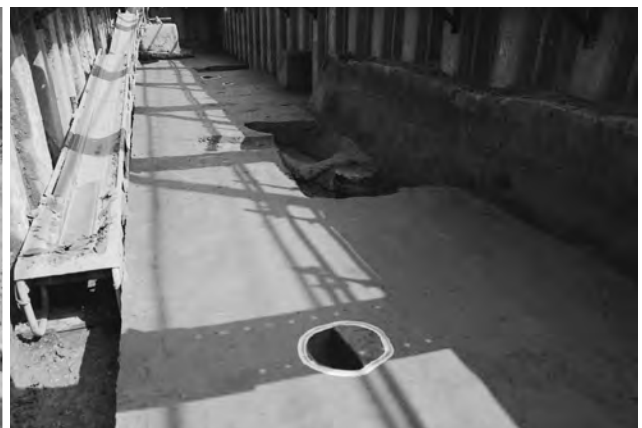
5. 10-1-1区東半部 第4遺構面 全景(北西から)
