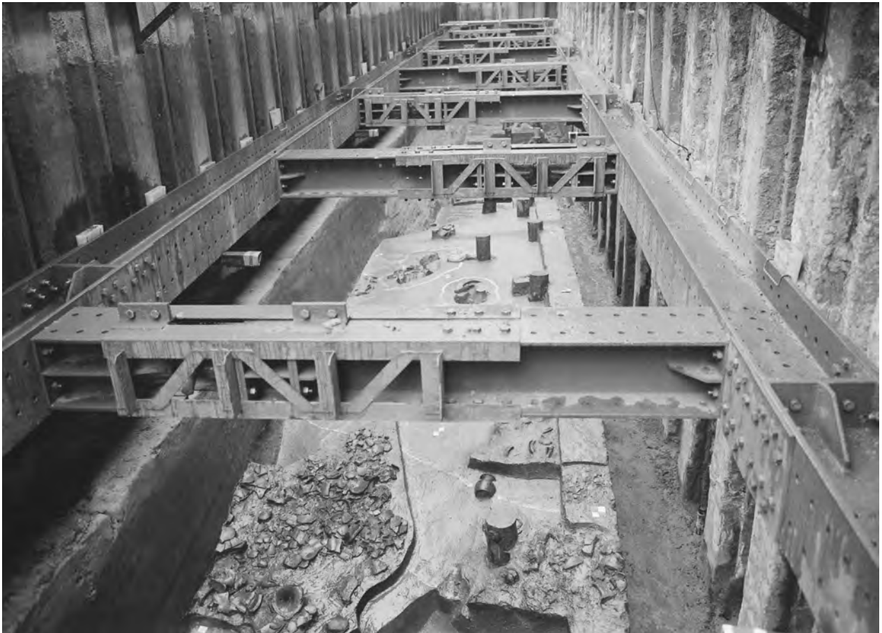
1. 10-1-1区中央部 第11遺構面 全景(東から)
