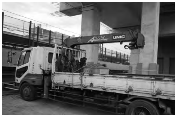
写真 23 銭貨埋納遺構 遺構搬送
