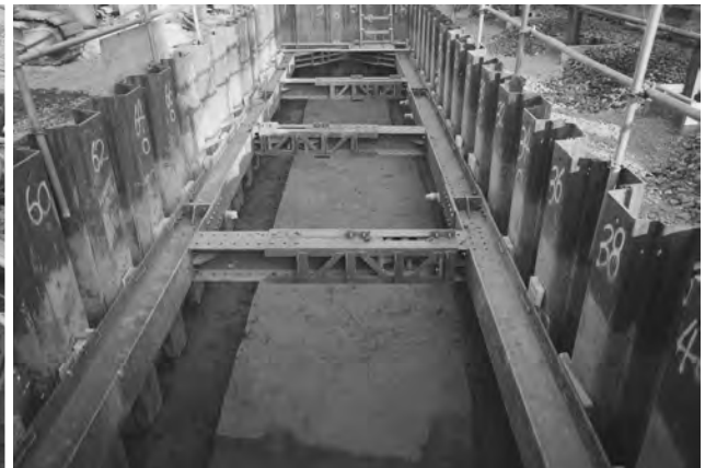
4. 10-1-6区 第9遺構面 全景(西から)
