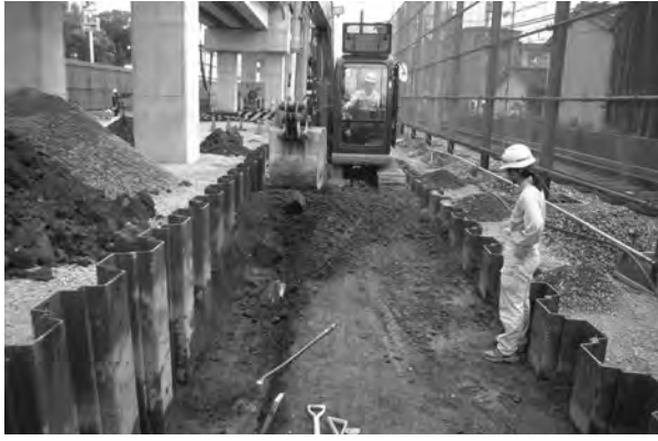
写真1 機械掘削作業
