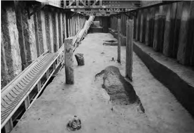
3. 10-1-1区東半部 第6遺構面 全景(西から)
