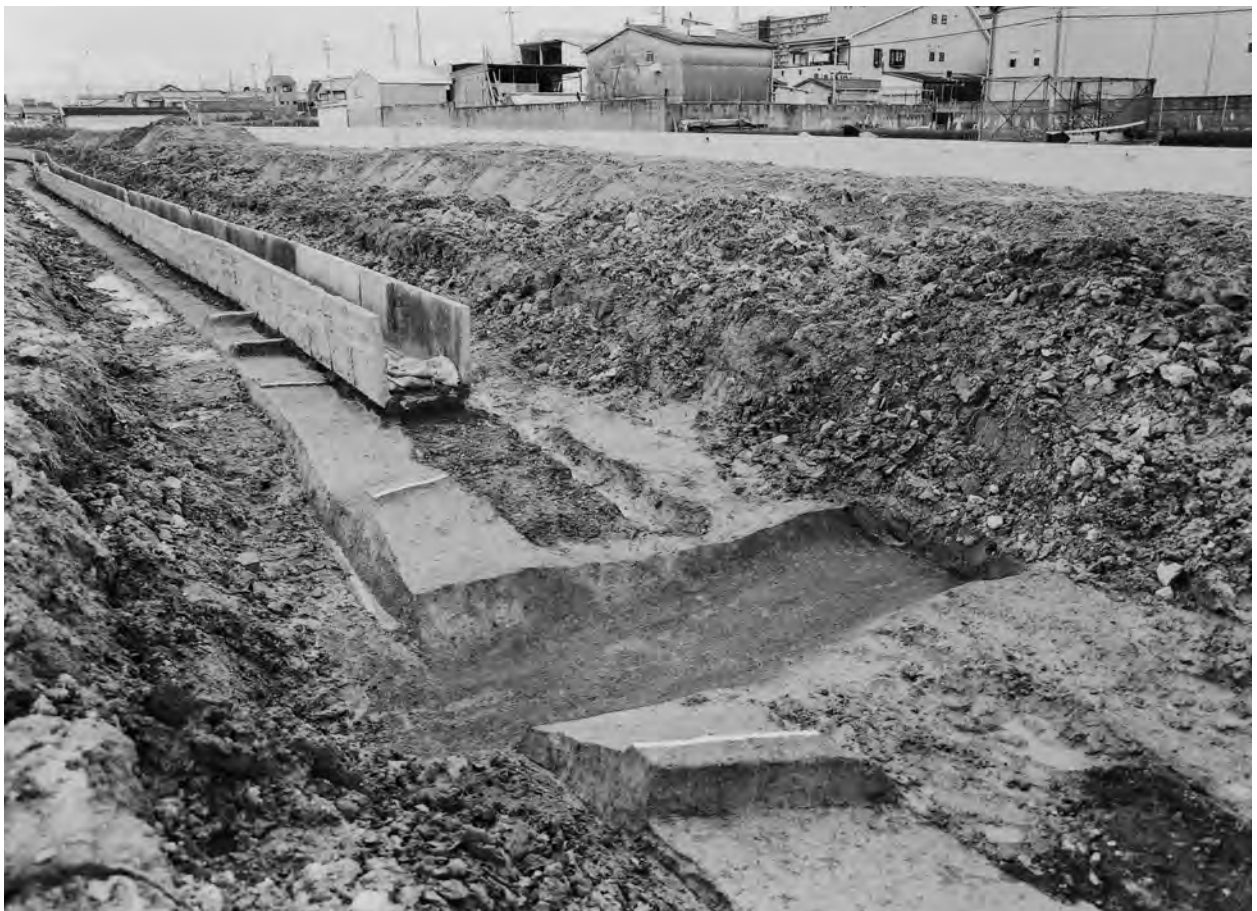
2. 09 - 3 - 8 区3溝検出状況 (北東から)
