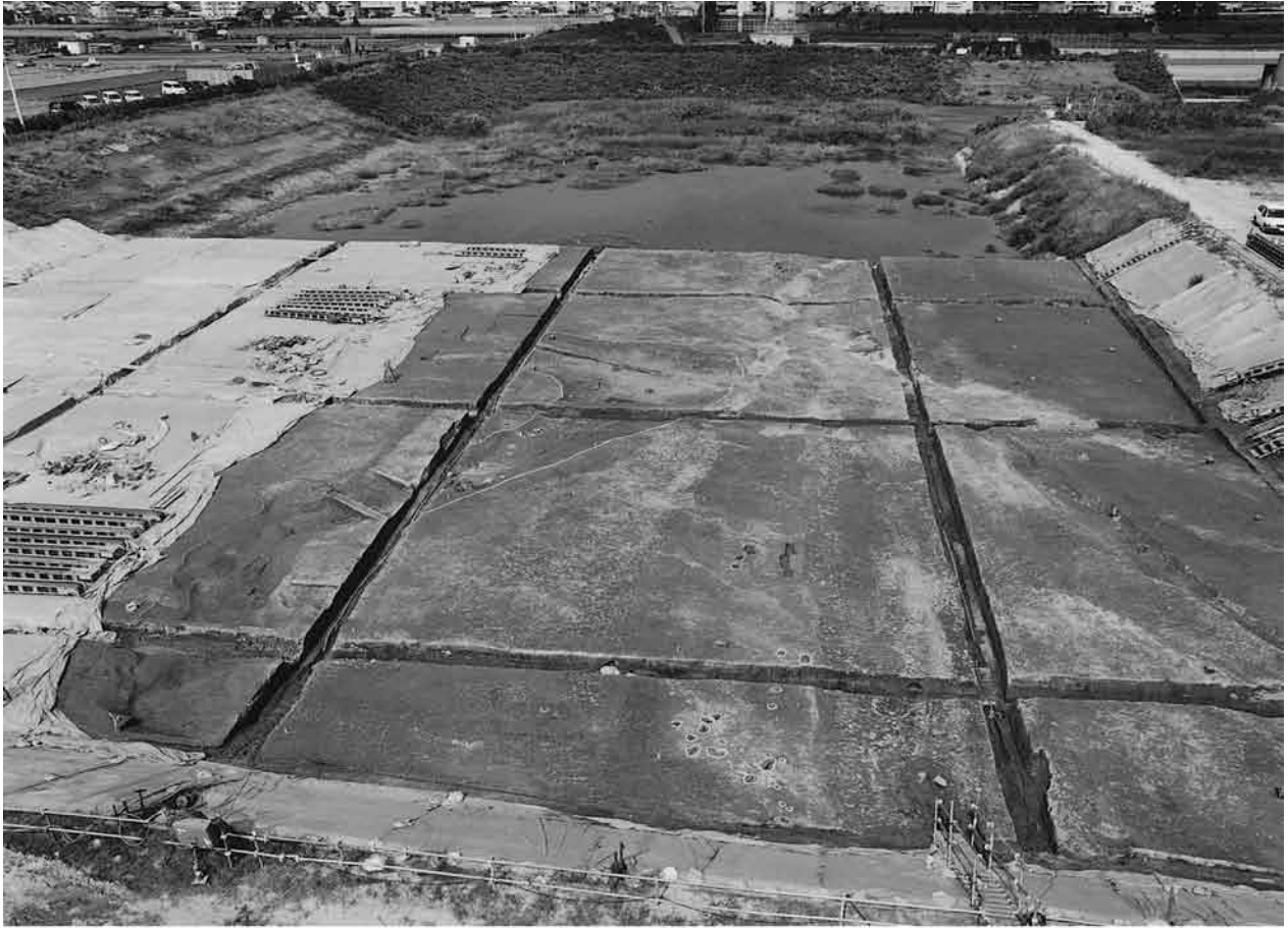
1. 第10b面 全景（東区、南から）
