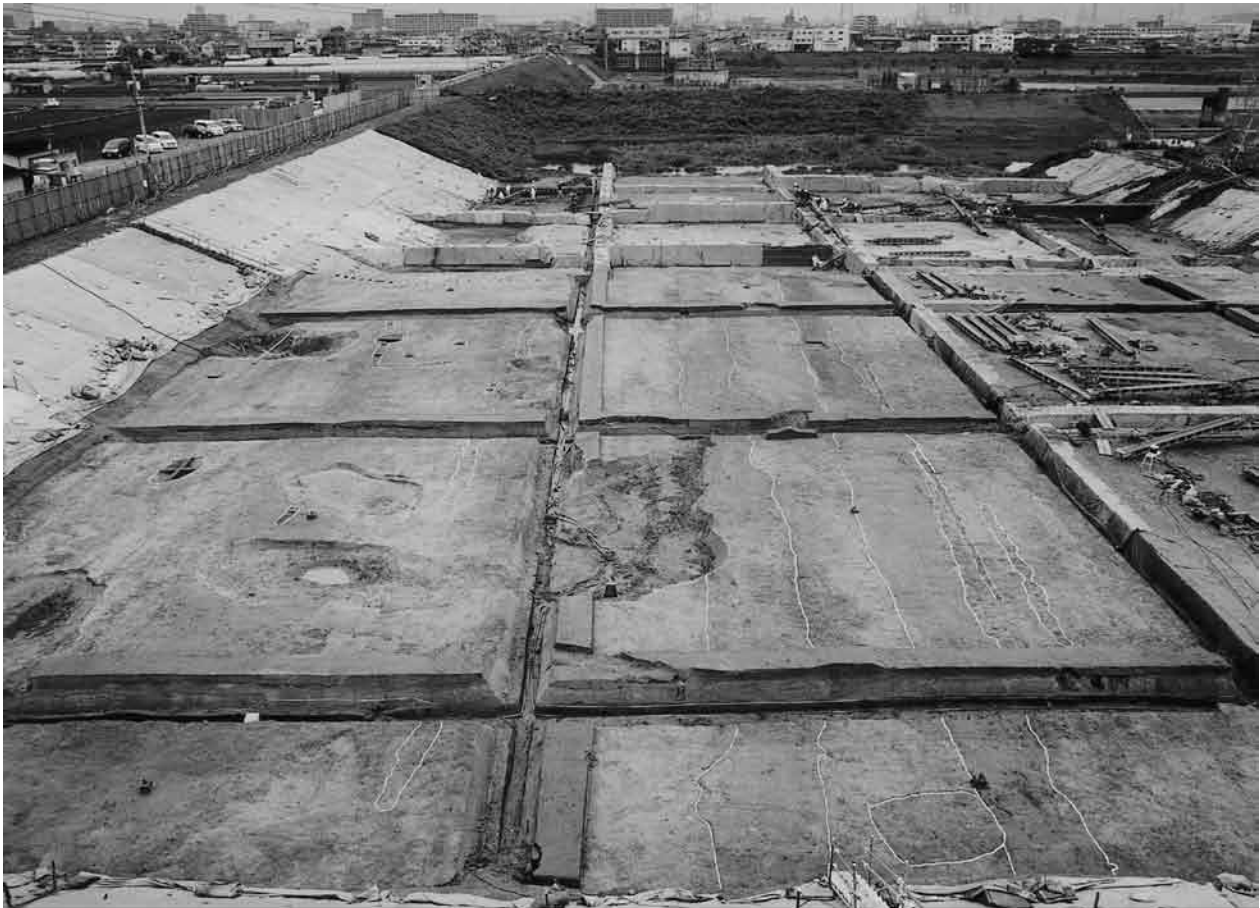
1. 第7-3面 全景 (西区、南から)
