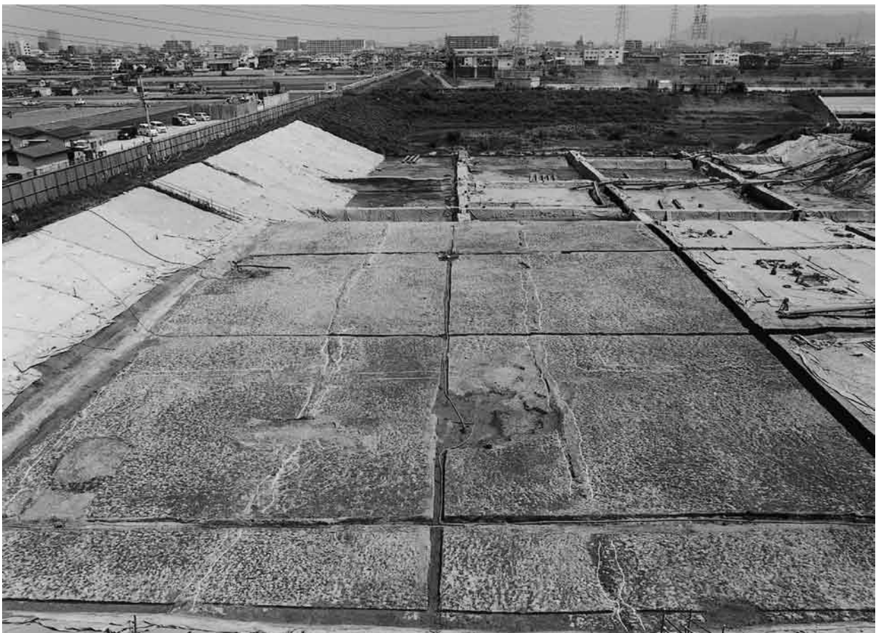
2. 第8面 全景（西区、南から）
