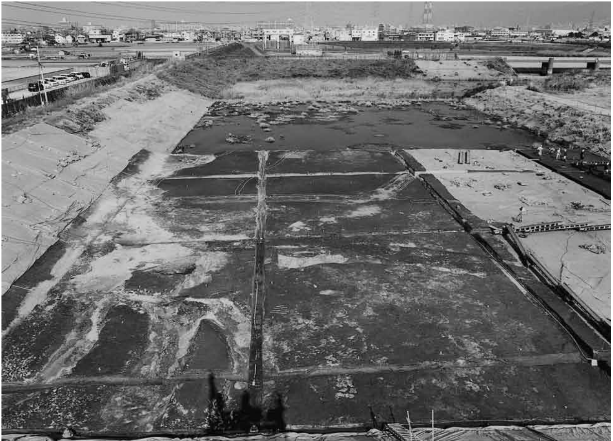
1. 第13面 全景（西区、南から）
