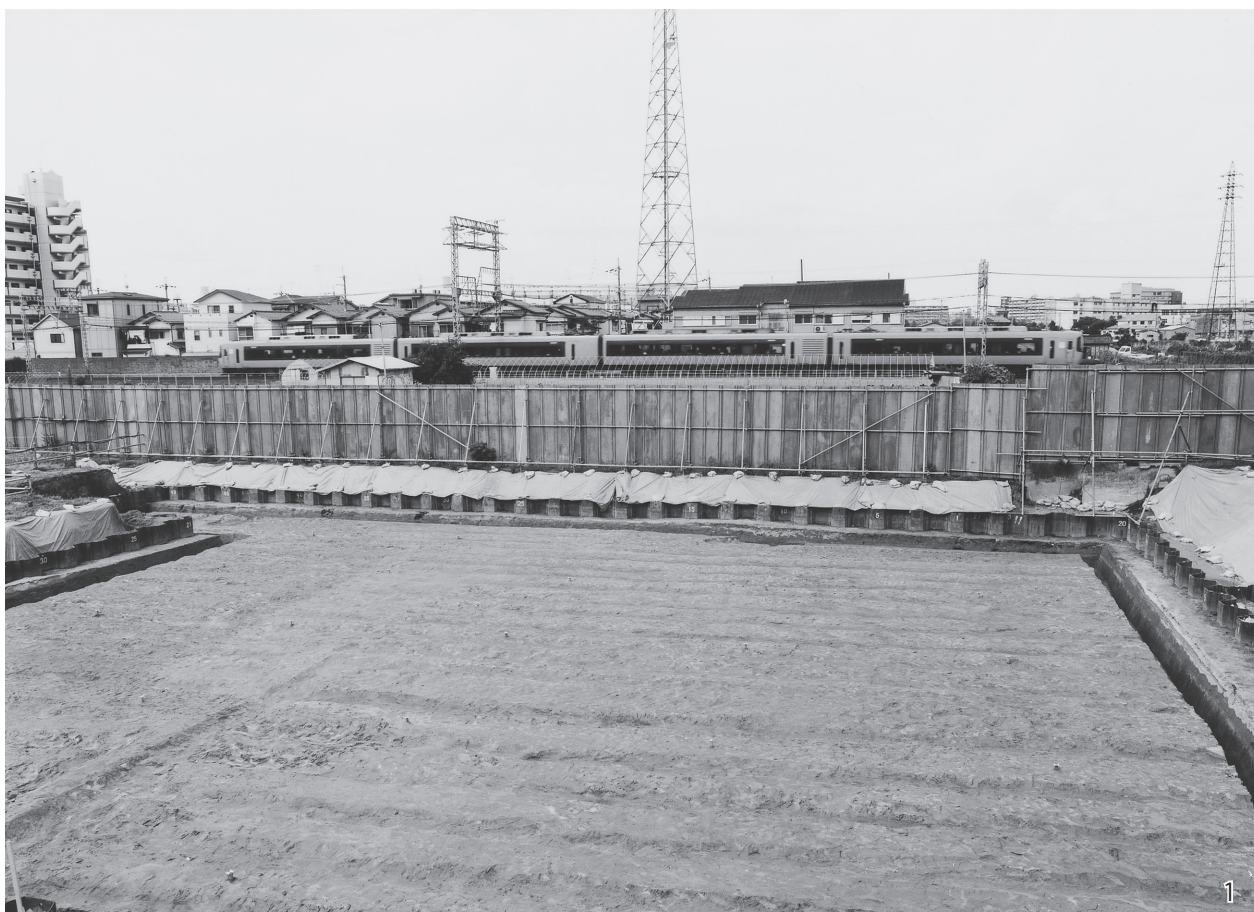
1 第3-1a面 1-2区 全景 (東から)
