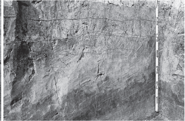
2. 北壁東端 第3層の細分 (南から)
