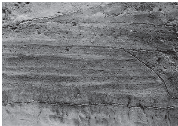
2 A区紀州街道堆積状況 [細部] (北側溝)
