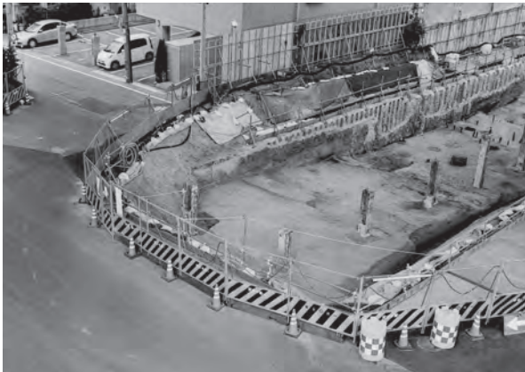
3 B区道5面全景 [手前は紀州街道迂回路] (東から)
