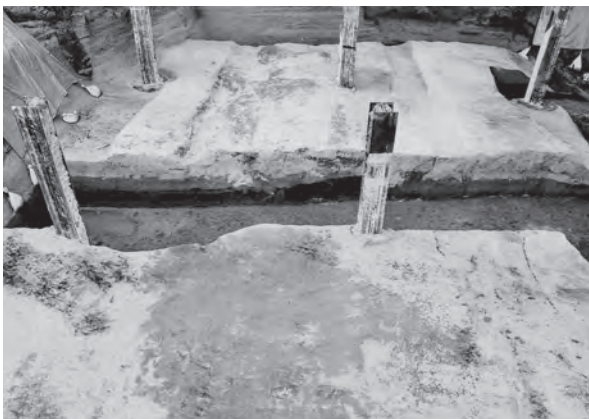
4 A区道7面全景 (北から)
