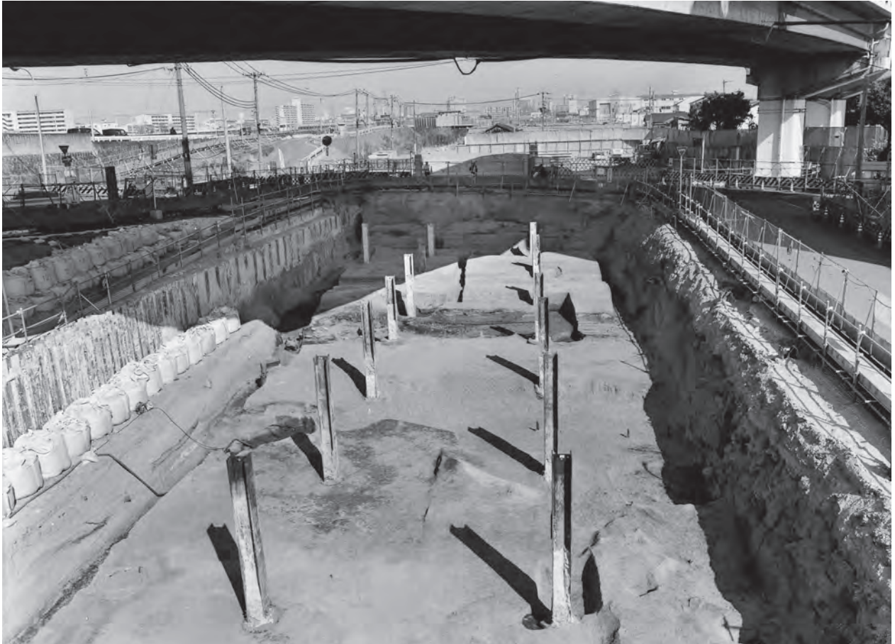
1 A区洪水砂層除去面全景〔紀州街道含む〕（西から）
