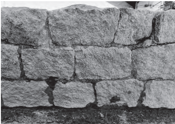
5 A区道2面東側石垣 [北部細部] (東から)
