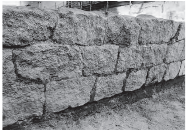
6 A区道2面東側石垣 [北部] (東から)
