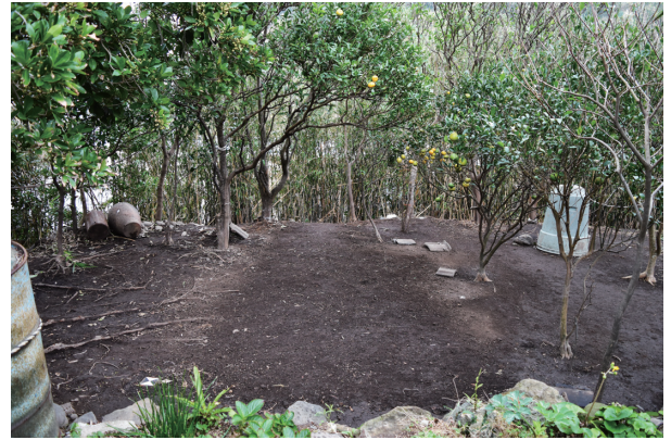
図12 第2地点1トレンチ埋め戻し完了状況（西側から） 原状に復した。
