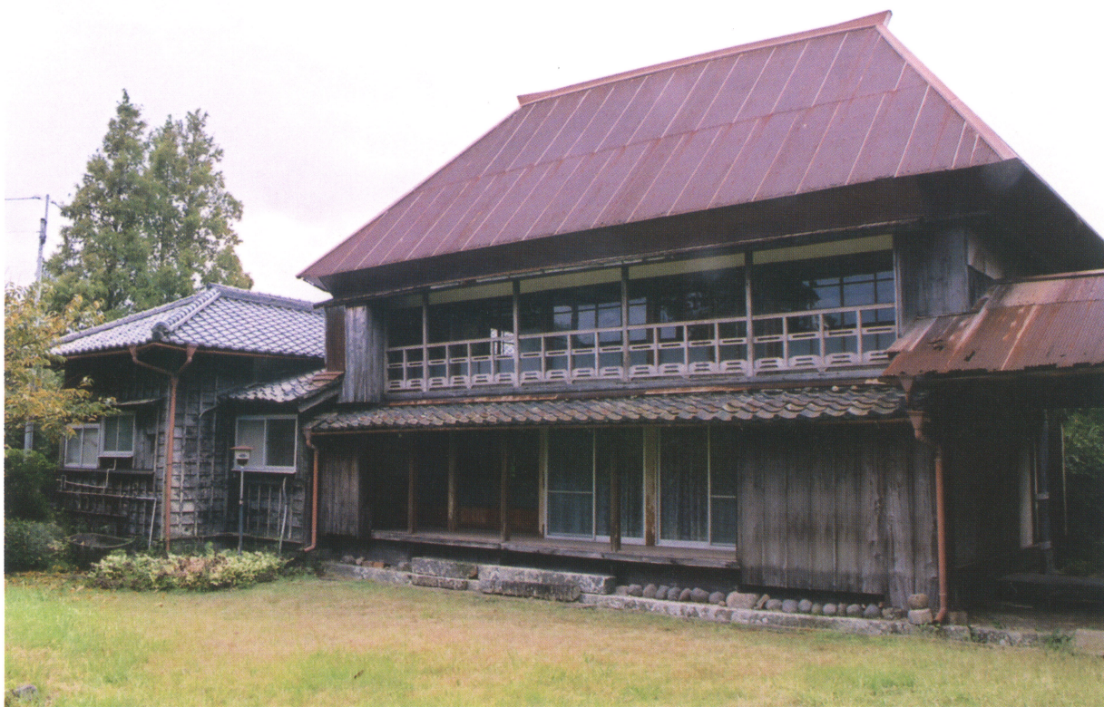
万延元年（1860）建造 隠居棟（写真提供 公益財団法人 文化財建造物保存技術協会）
