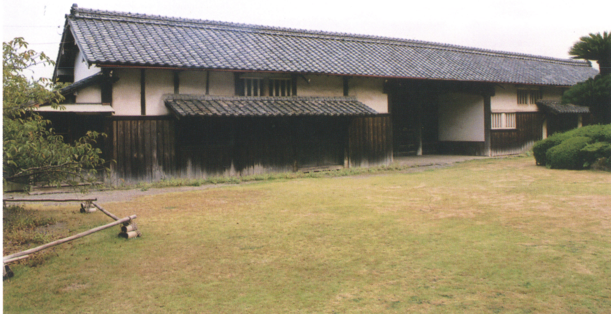
文久二年（1862）建造 長屋門庭園側（写真提供 公益財団法人 文化財建造物保存技術協会）
