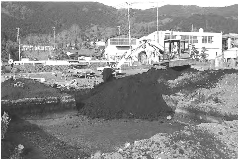
写真32 重機による埋め戻し
