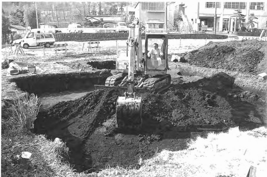
写真4 重機による スコリア層剥ぎ取り
