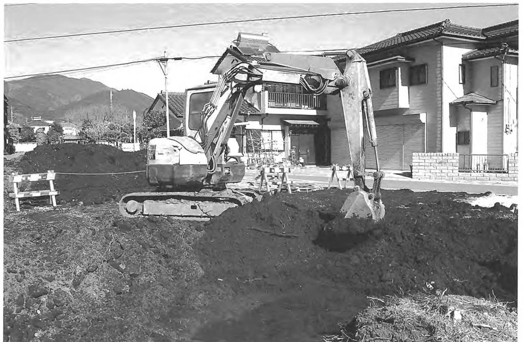
写真3 重機による表土剥ぎ
