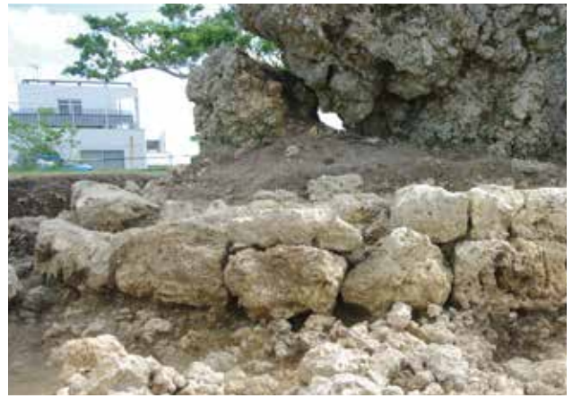
2. 石積み6西側（南西から）
