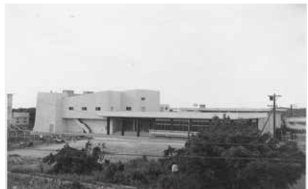
図版4 建設中の琉球政府立博物館
