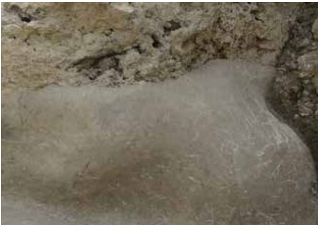
4. 溜池2モルタル湾曲部（トレンチ8、南から）
