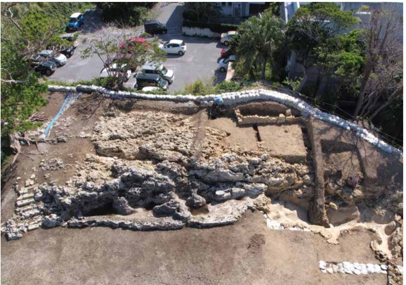
2. 庭園跡（上空北から）
