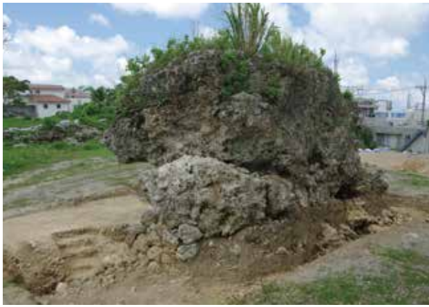
1. 拝所周辺遺構（北東から）
