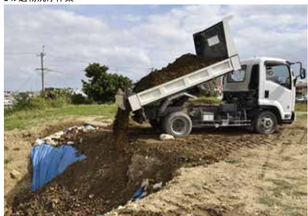
16. 重機による埋め戻し作業（トレンチ5）
