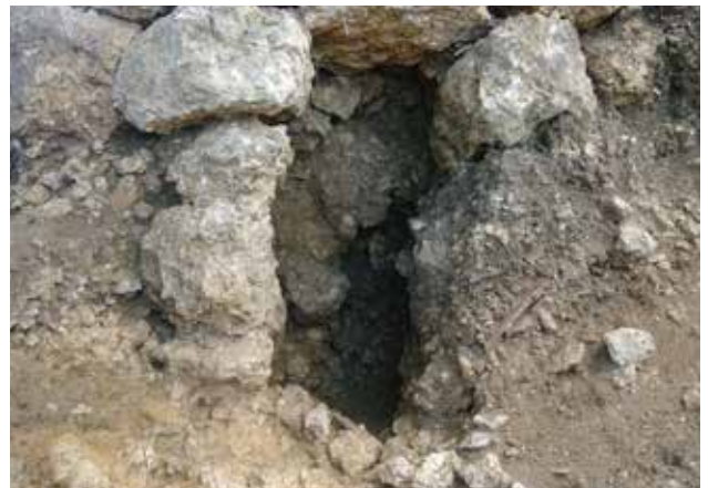
4. 石積み1東側開口部（東から）
