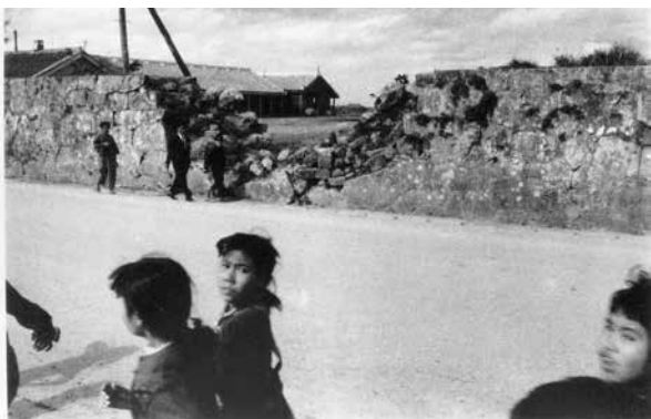
図版3 中城御殿跡正門付近
