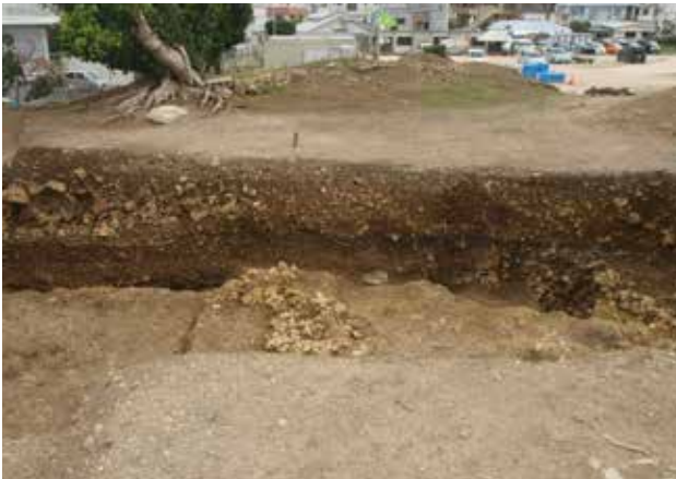
3. トレンチ6東壁（西から）
