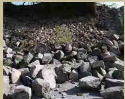
崩壊した熊本城の百間石垣(画像提供:熊本県立美術館)
