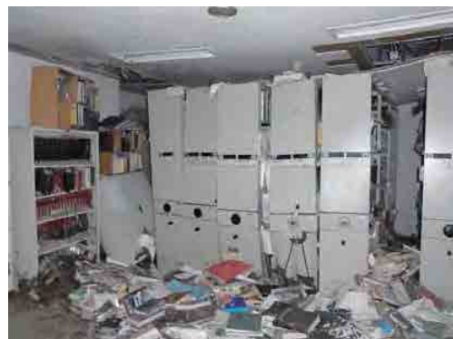
②1階書類保管庫(石巻文化センター)
