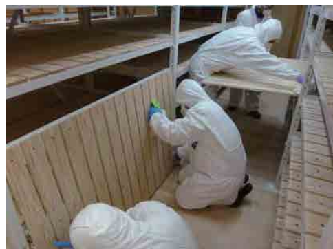
②改修後の収蔵庫の清掃(工事中の塵埃を除去し、安全性を確認)
