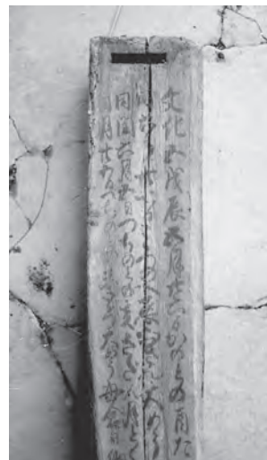
図3 水車小屋に使用されていた柱
