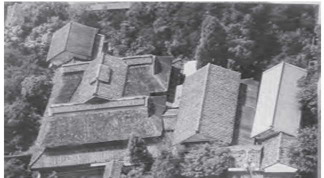
図2 上空から撮影した旧大國家住宅
