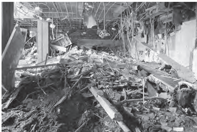
図3 市博1階展示室の2011年4月21日の状況(市博前館長本多先生撮影)。50cmあまりの津波堆積物と博物館資料・什器が混ざり混沌とした状態。
