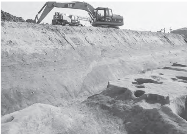
7. 11-1:5-2区 X=-134,860 ライン付近 (北から)
