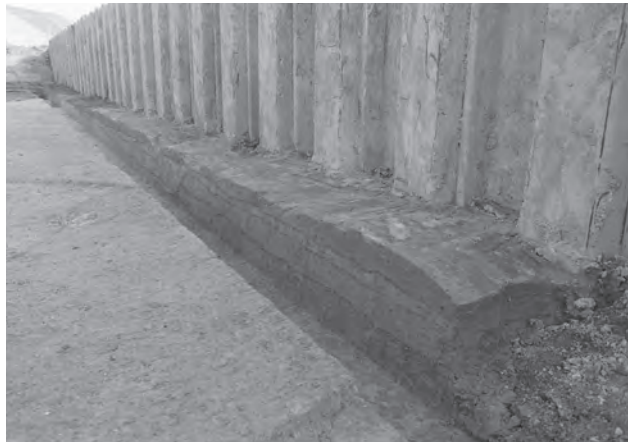
4. 12-1:17-2区南半部 南壁断面 (北西から)
