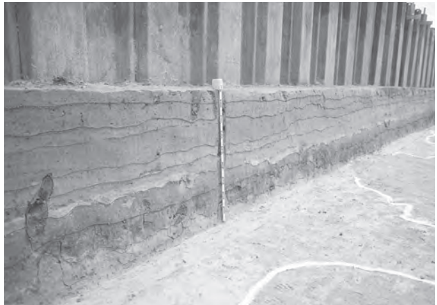
4. 10-2:2-1-2区 X=-135,380 ライン付近 (北東から)
