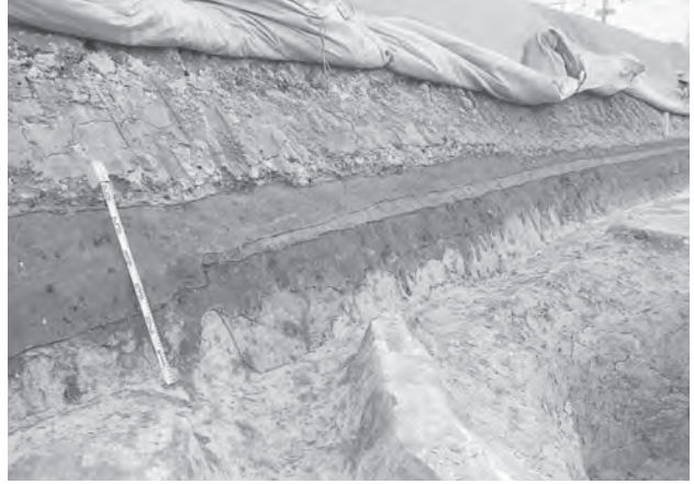
2. 11-1:1-1区 X=-135,530 ライン付近 (北から)
