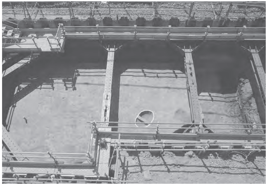
1. 12-1:17区南東端部 地山上面全景 (北西から)
