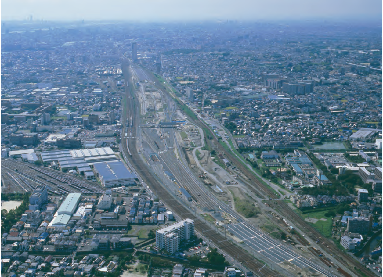
1. 吹田操車場遺跡・明和池遺跡 全景（北東から）平成22（2010）年10月5日撮影
