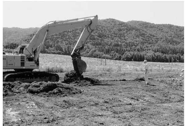
2 表土除去(北から)
