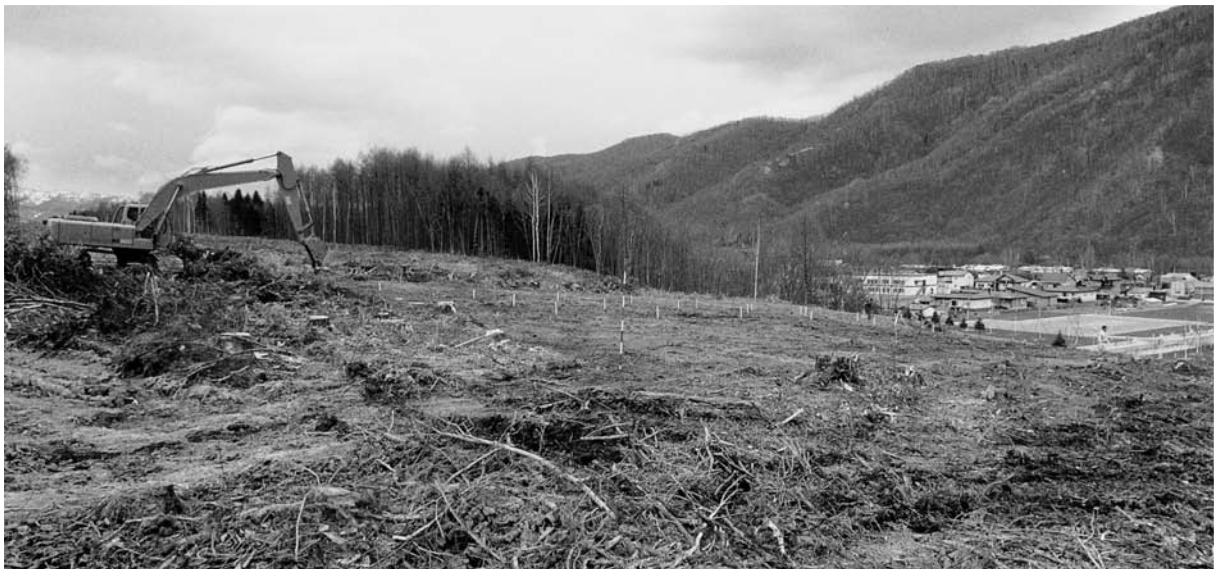
2 表土除去・杭打ち (南東から)
