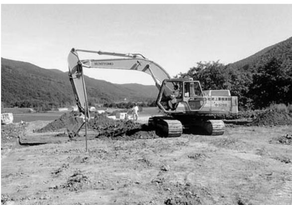
4 重機調査区重機調査状況 (南西から)
