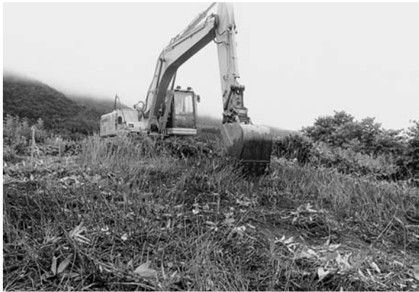
1 笹根除去・伐根状況(北東から)
