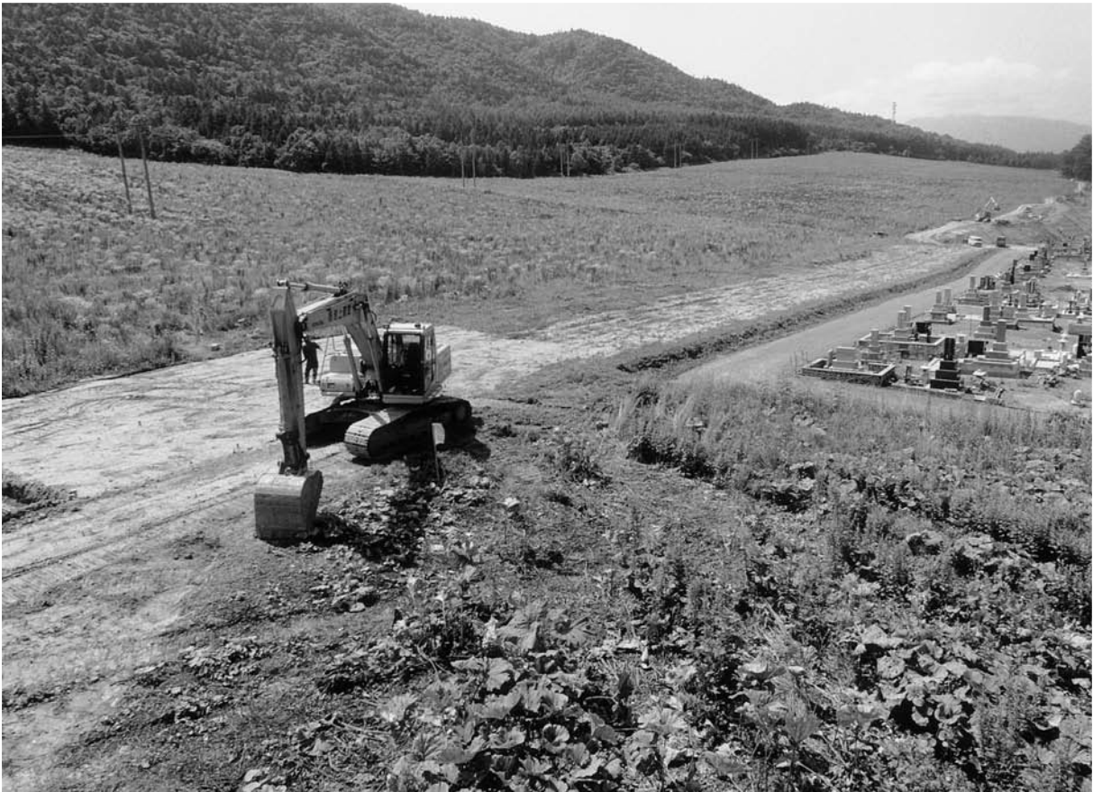
1 重機調査区調査前 (北東から)
