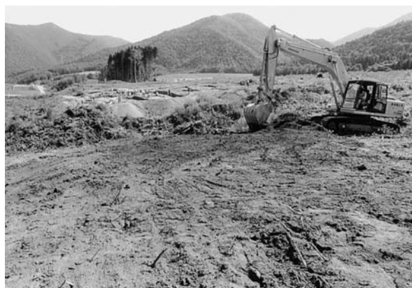
2 表土除去 (南西から)
