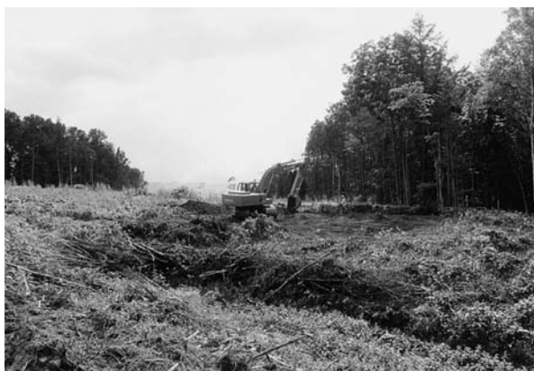
1 笹根除去・伐根状況 (東から)
