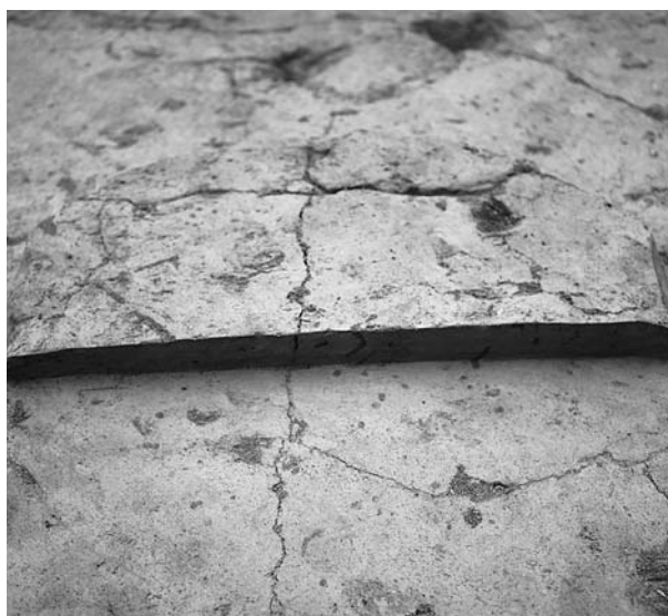
F-35 土層断面(西から)
