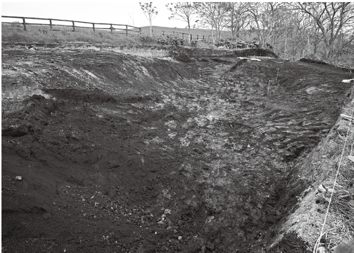
沢部埋め土除去完了(北西から)
