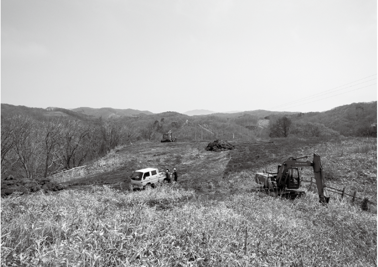
調査区東側表土除去作業(北西から)
