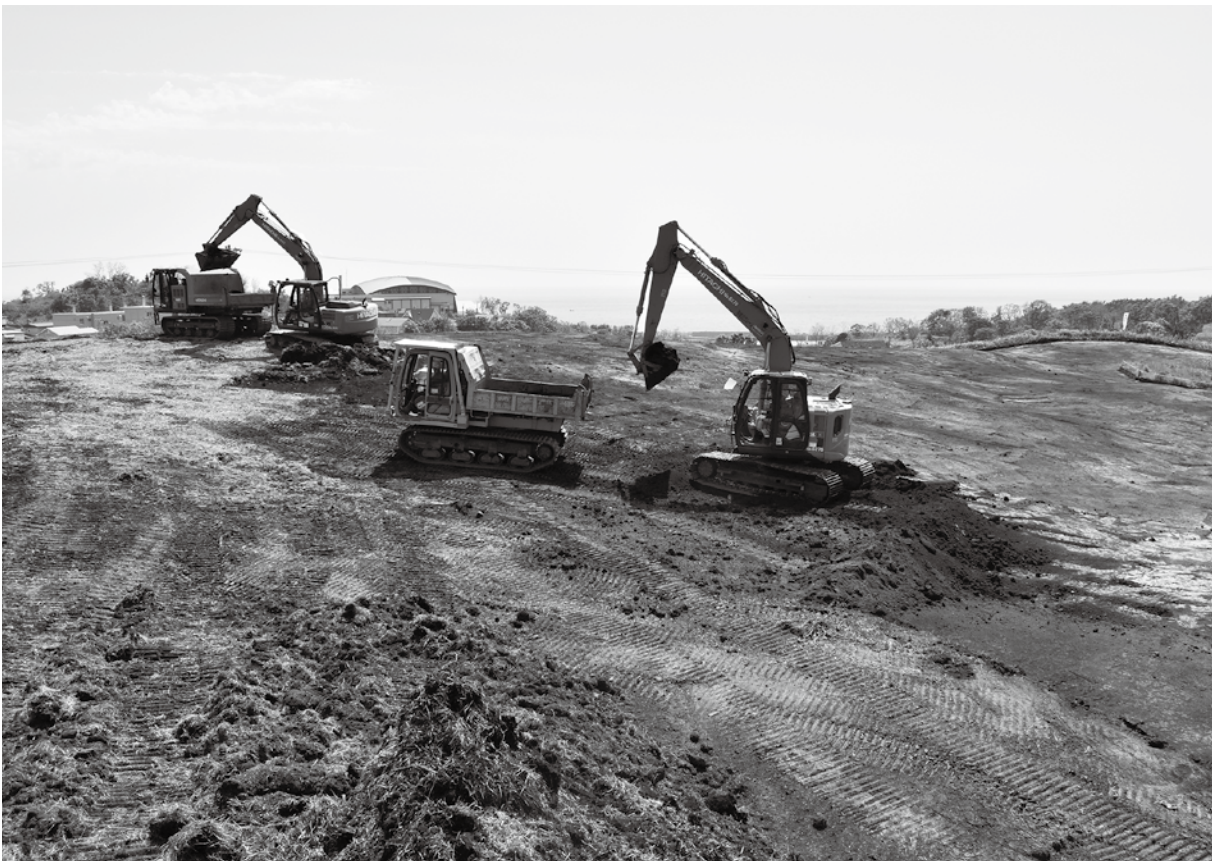
調査区中央表土除去作業(北東から)
