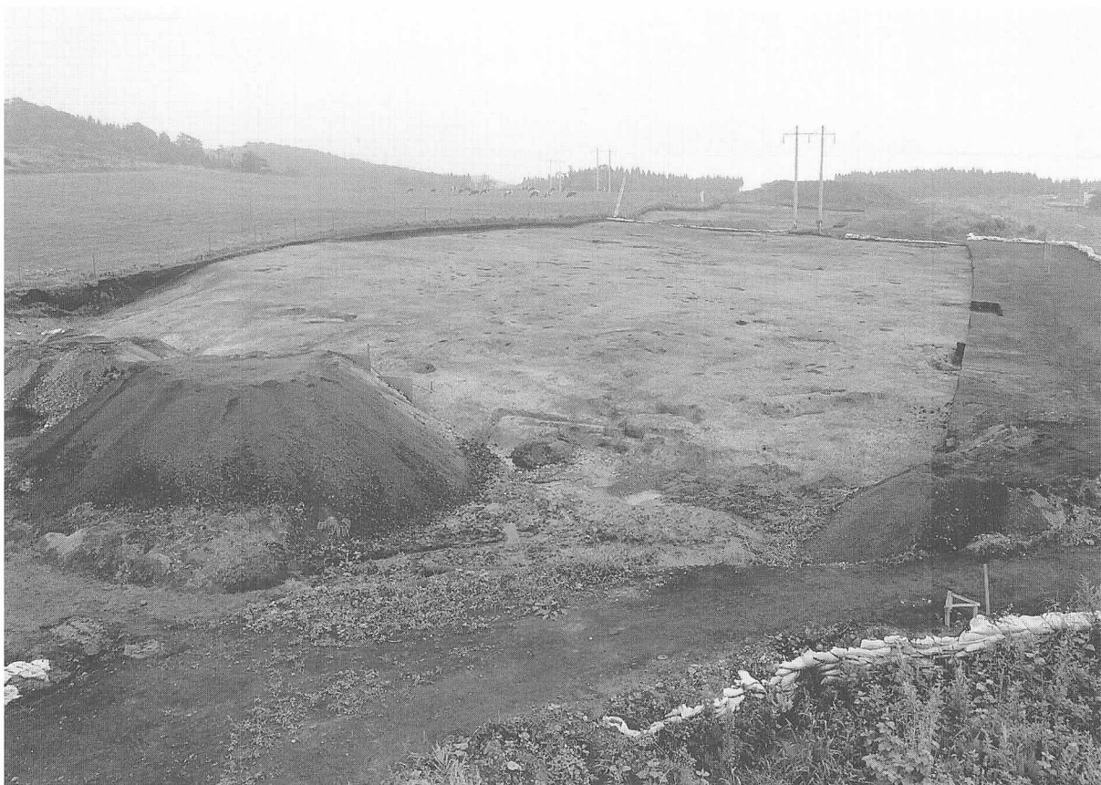
1. B1地区完掘 (南から)
