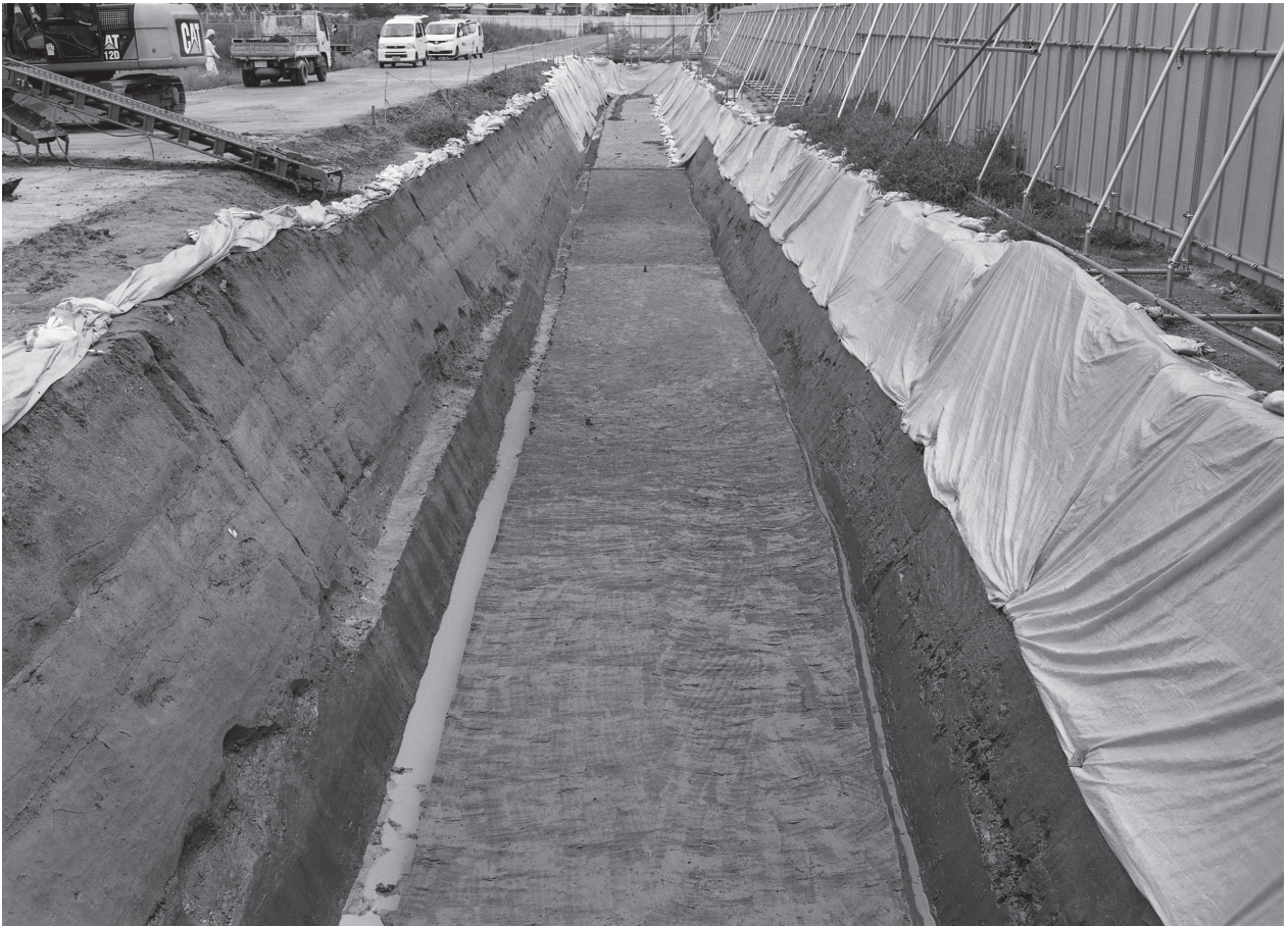
4. 1区 第8a面 西半 (西から)
