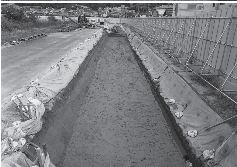
3.2区 第3a面 西半 (西から)
