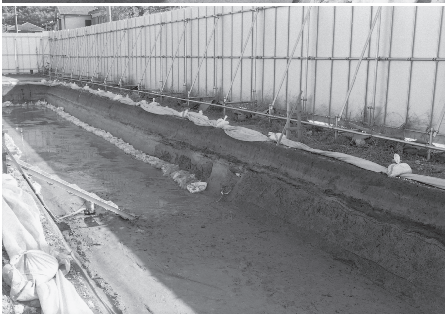
3. 3区 調査区断面 東半 (北西から)
