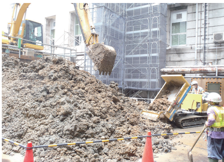
写真12 中－2区 1次・2次掘削土砂集積状況
