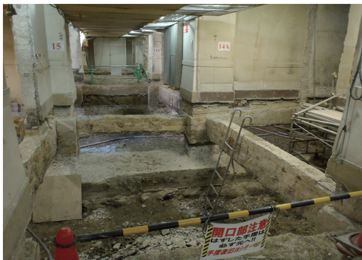
写真11 中－2区 1次・2次掘削状況
