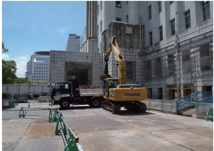
写真9 北-2工区 3次・4次掘削土搬出状況
