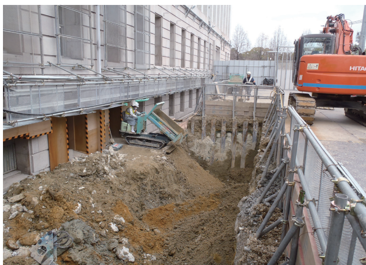
写真16 南－1工区 1次・2次掘削土搬出状況
