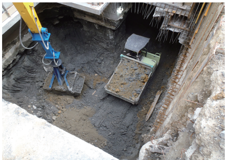
写真14 中－1工区 3次・4次掘削搬出口
