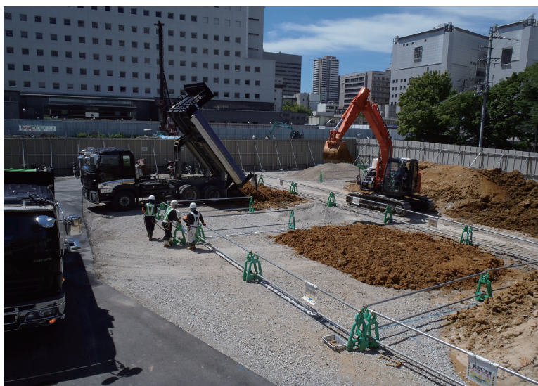
写真5 事務所前掘削土搬入状況（3次・4次掘削）
