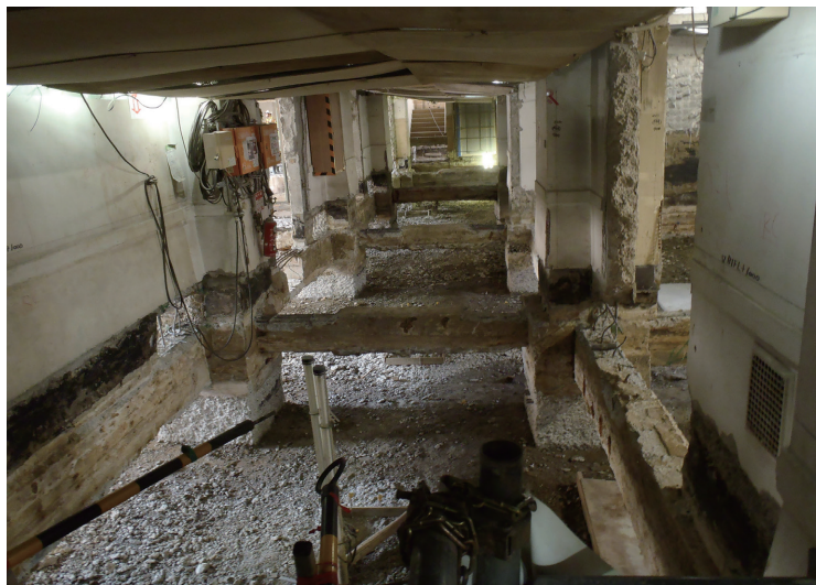
写真15 南－2工区 1次・2次掘削状況
