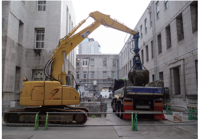
写真13 中－1工区 3次・4次掘削土搬出状況
