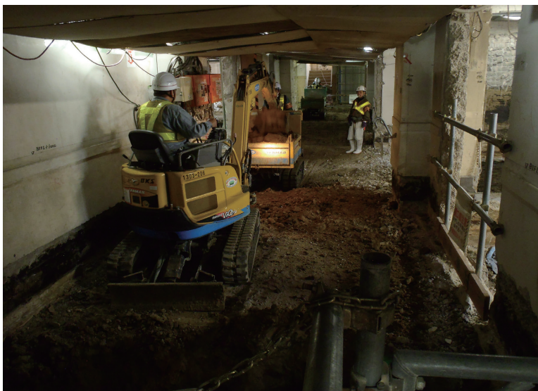
写真1 1次・2次掘削状況（南一2工区）
