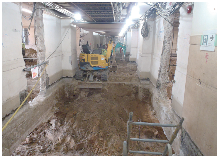
写真7 北一2工区 1次・2次掘削状況
