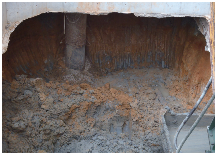
写真10 北-2工区 3次・4次掘削土層断面
