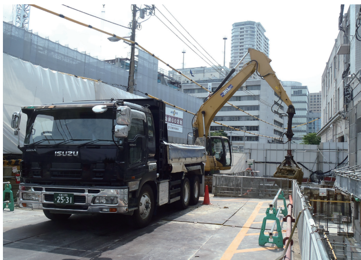
写真17 南一工区 3次・4次掘削土搬出状況
