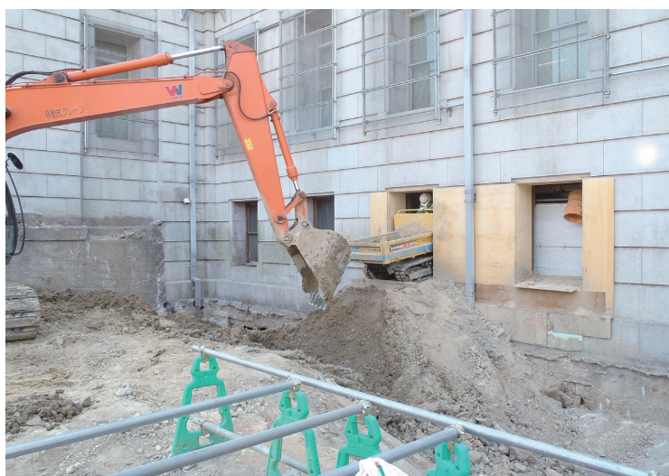
写真8 北一2工区 1次・2次掘削土搬出状況
