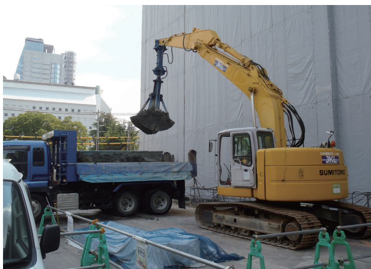
写真18 南二工区 3次・4次掘削土搬出状況
