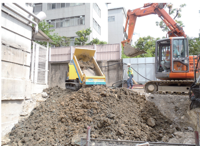
写真2 1次・2次掘削土集積状況（北工区）
