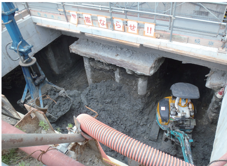
写真4 3次・4次掘削搬出口（南一工区）
