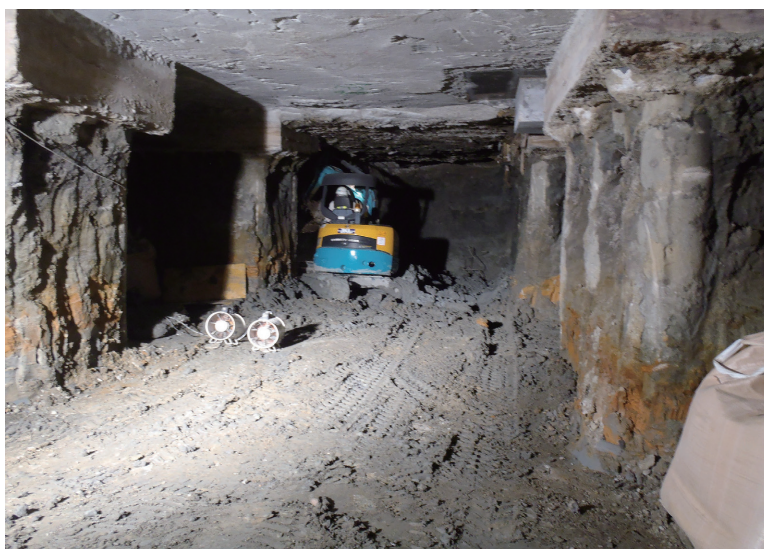
写真3 3次・4次掘削状況（北一2工区）
