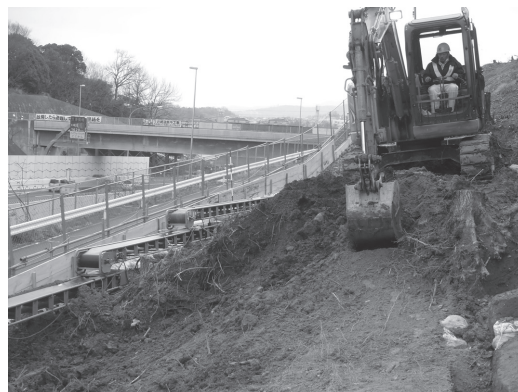
写真2 表土層掘削状況
