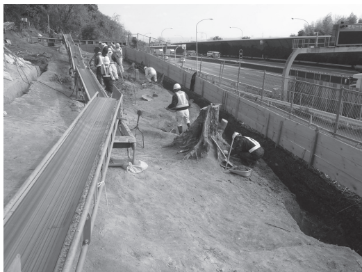
写真3 包含層掘削状況
