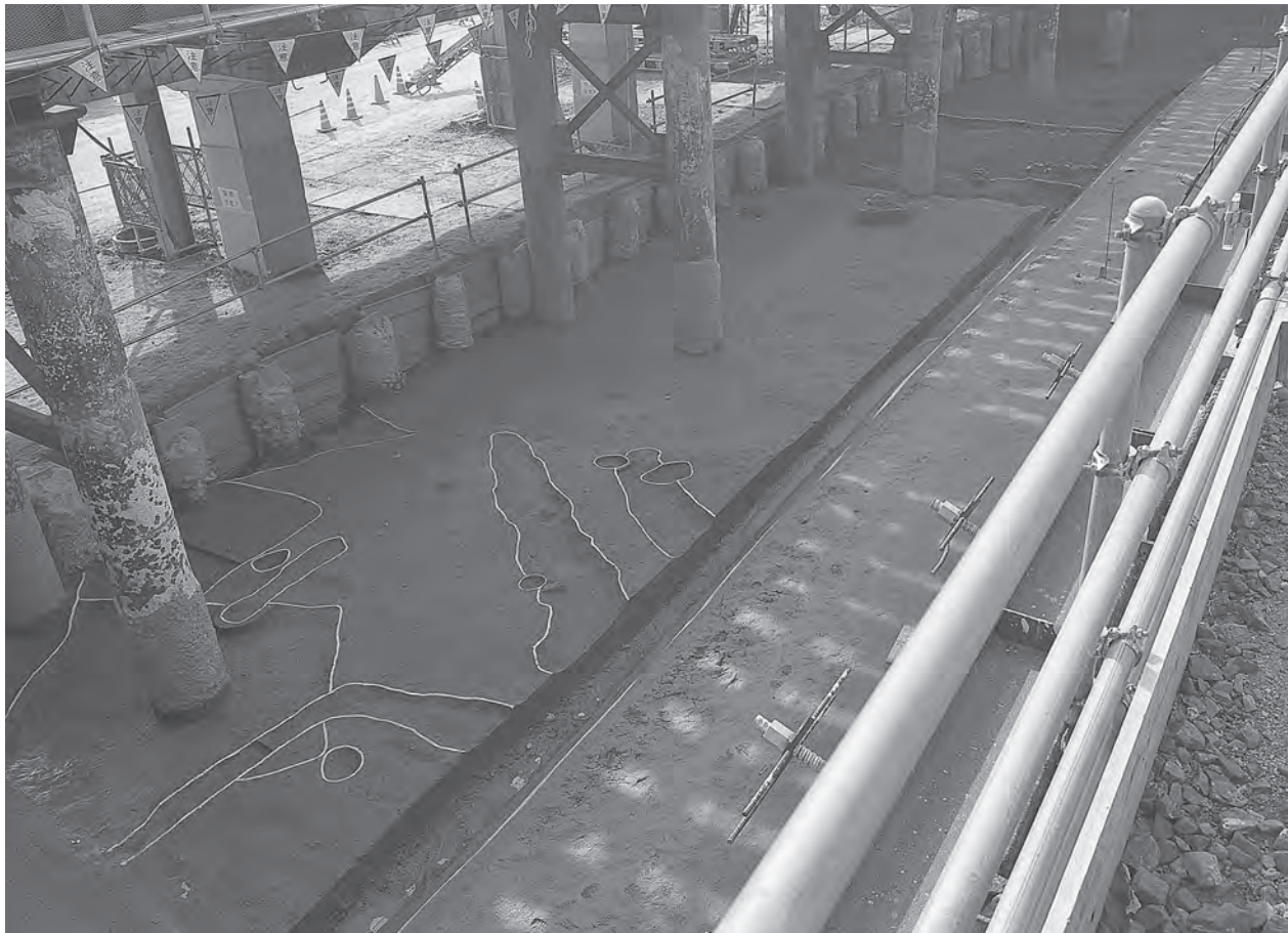
1. 第4-2層除去面検出状況 [北東から]
