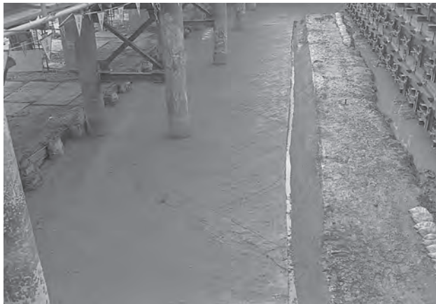
1. 第1層除去面検出状況 [北東から]
