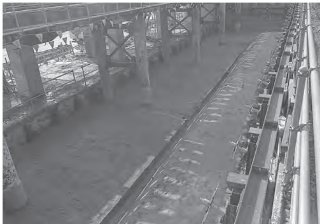
7. 第3-2層除去面検出状況 [北東から]
