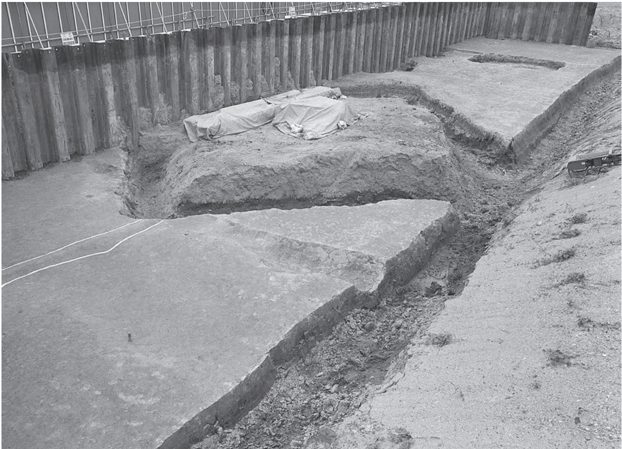
1. 第6層 遺構全景 (5トレンチ) (南東から)
