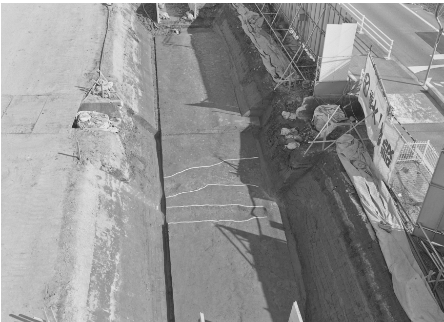
3. 3区 第8a層上面 全景（西から）
