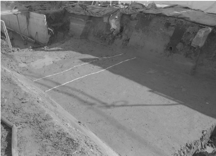
2. 2区 第3a層上面 全景（北西から）
