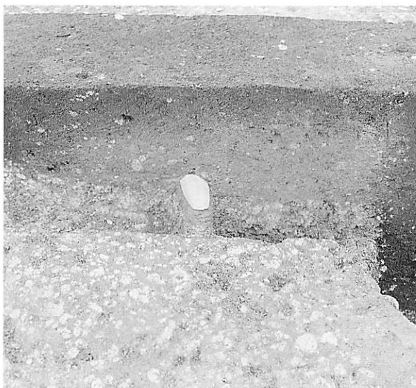
2 H-25F-1セクション(SW→NE)
