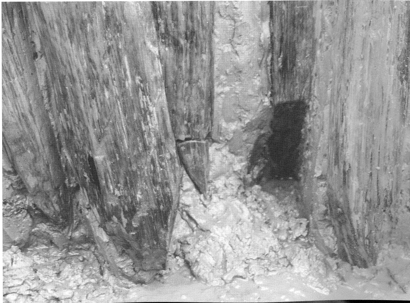
28区杭先端部の様子
