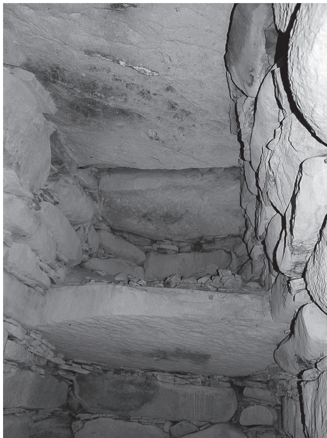
写真10 大峰古墳：石棚と天井石
