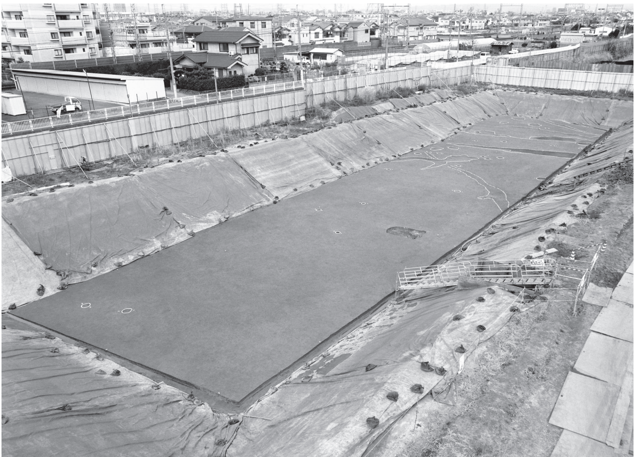
29、1区第12面全景（南東から）
