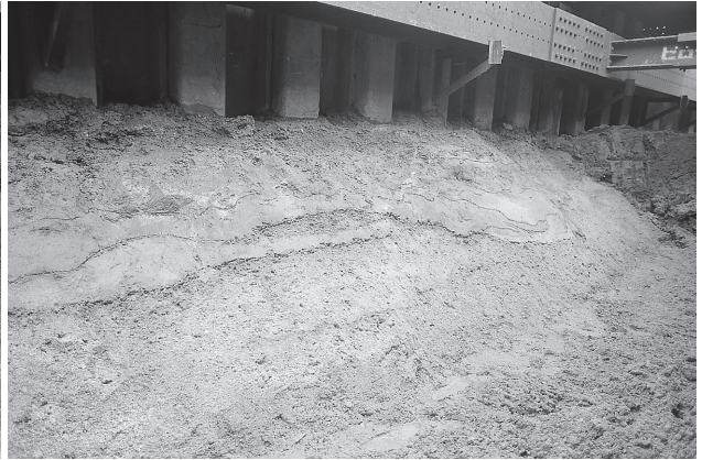
2. II区 東壁土層断面 (X= - 156,605 あたり) (北西から)
