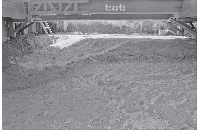
2. 1区 東西断面② (南東から)
