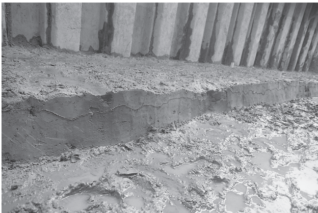
3. II区 東壁土層断面 (X= - 156,605 あたり) (北西から)
