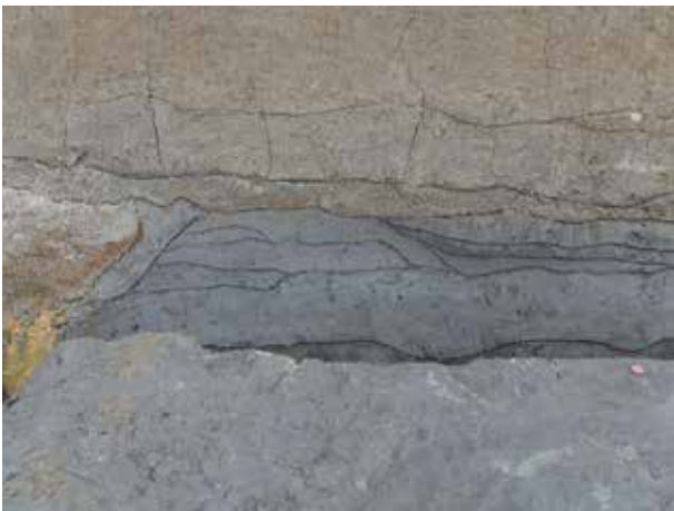
19. 1区 流路6西岸断面（調査区南壁、北から）
