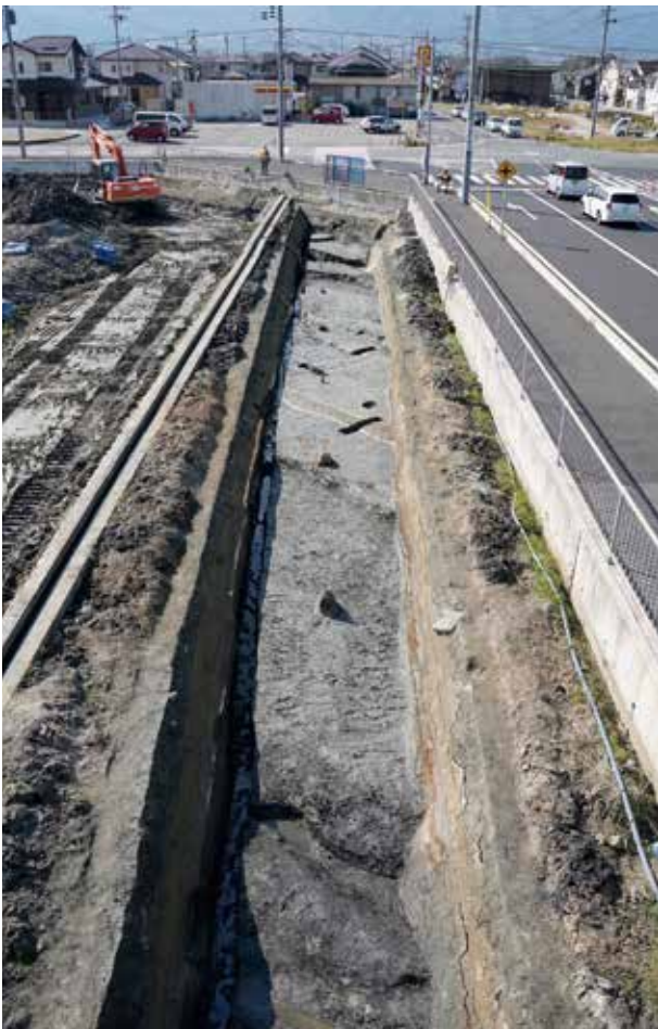
52. 4-3区 第2遺構面完掘（東から）
