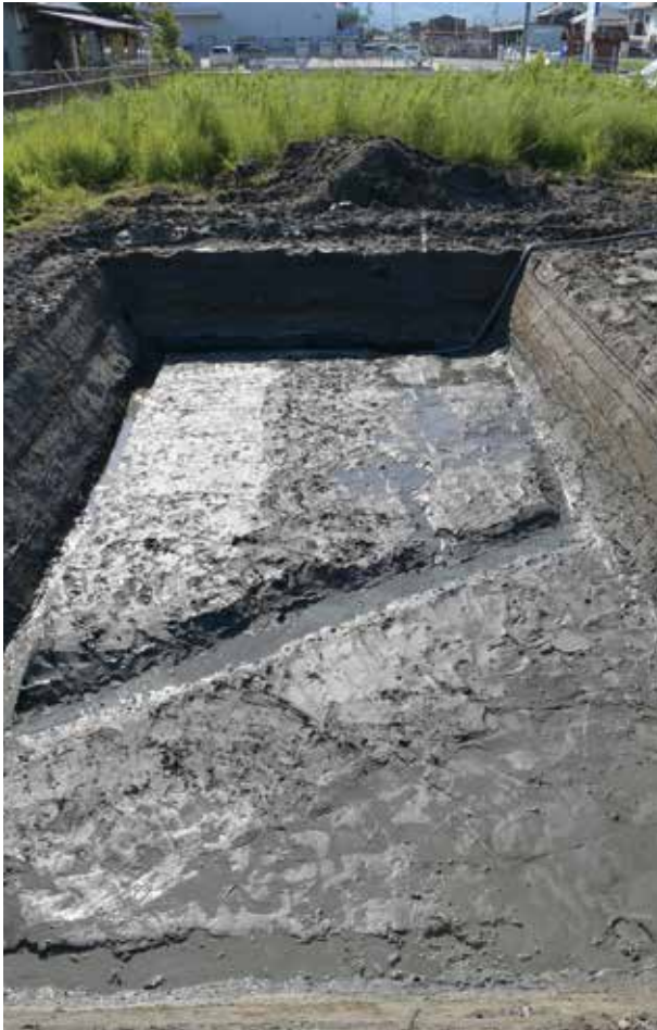
35. 3区 第1遺構面完掘（東から）
