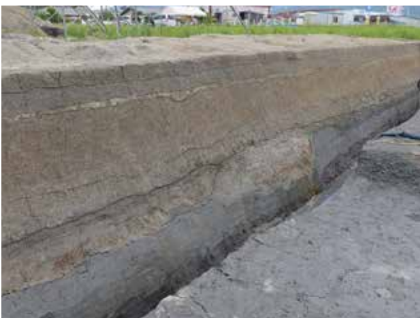
21. 1区 調査区南壁（北東から）
