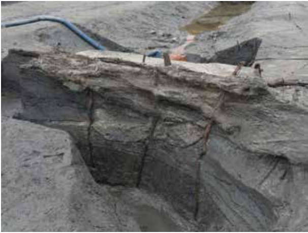
15. 1区 流路5堰（東から）
