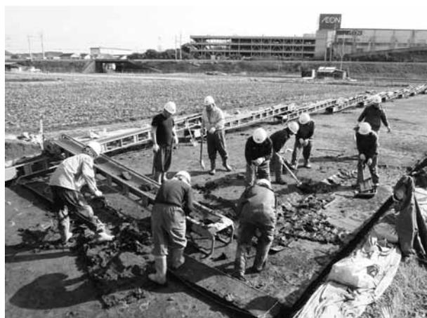
写真2 人力掘削作業状況
