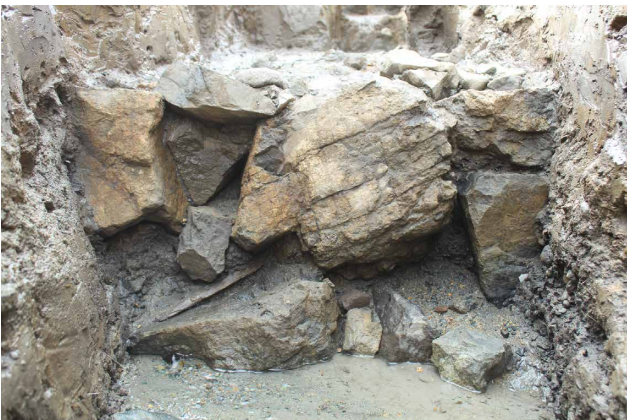
石垣近景（東から/平成30年度）
