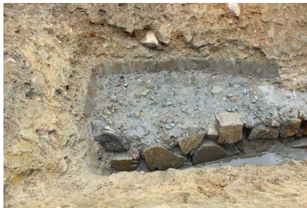
調査区南側石垣・裏込状況（東から/令和元年度）
