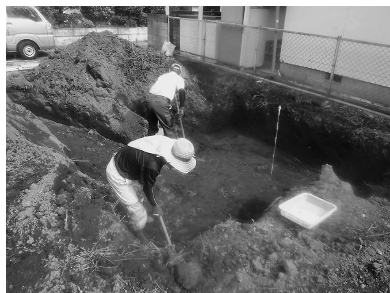
掘削作業状況 (2)
