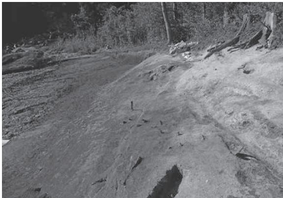
1号切土整地全景（東から）
