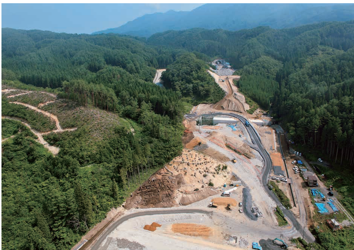
建設中の三陸沿岸自動車道と間木戸 I 遺跡（南から）
