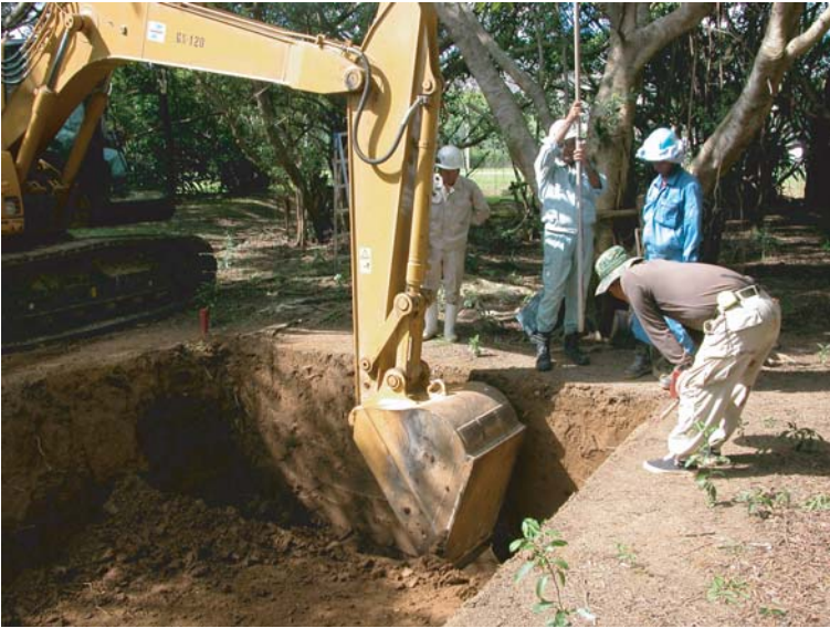
第6期試掘調査状況 重機による掘削状況
