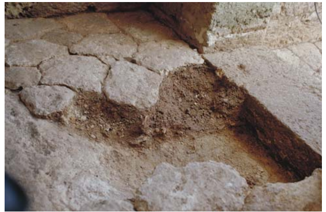
墓室内敷石造成状況
