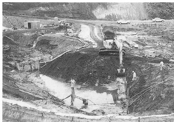
2 C地区準備工事状況 W→
