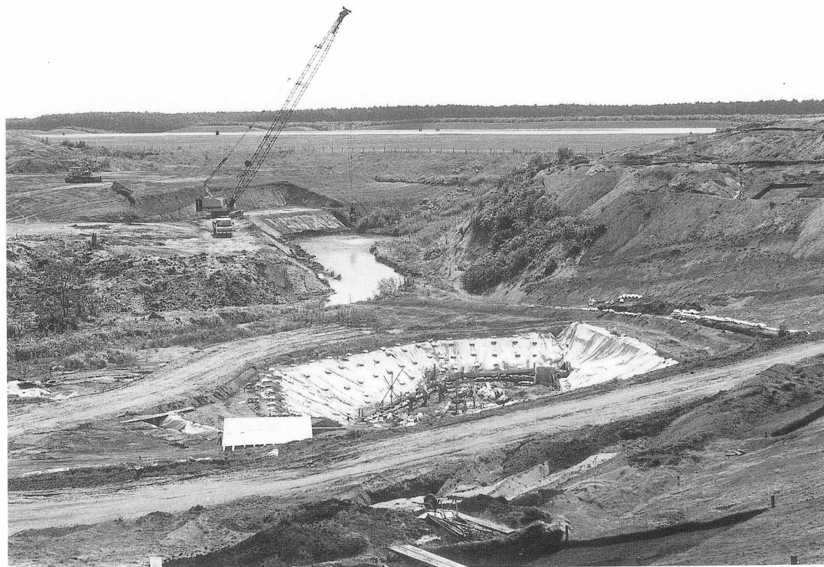
2 低湿部調査状況 NE→
