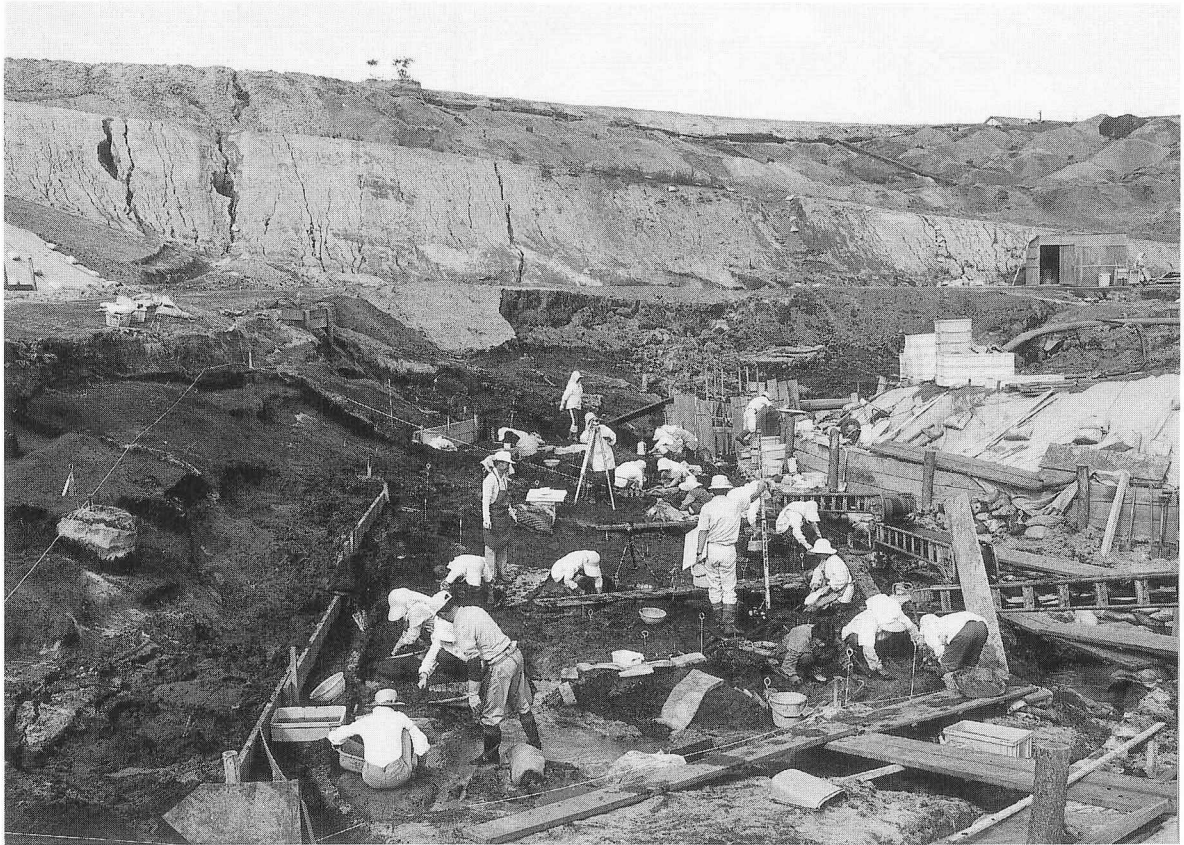
1 C地区調査状況 SW→
