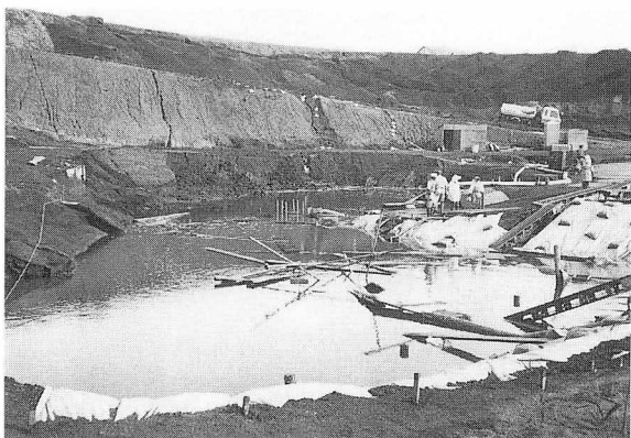
3 C地区冠水状況 W→
