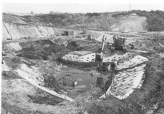
4 C地区カマ場工事状況 W→
