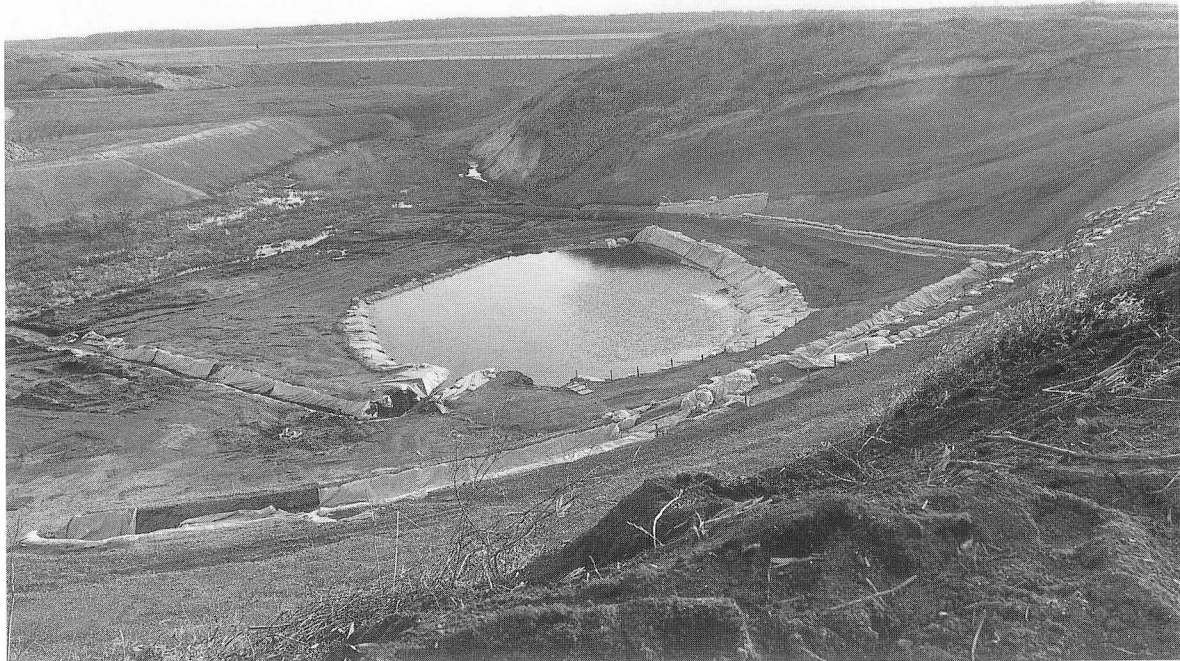
1 低湿部調査前状況 NE→
