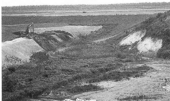
1 B地区クラムシェル足場造成状況 NE→
