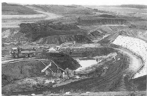
1 C地区準備工事状況 NE→
