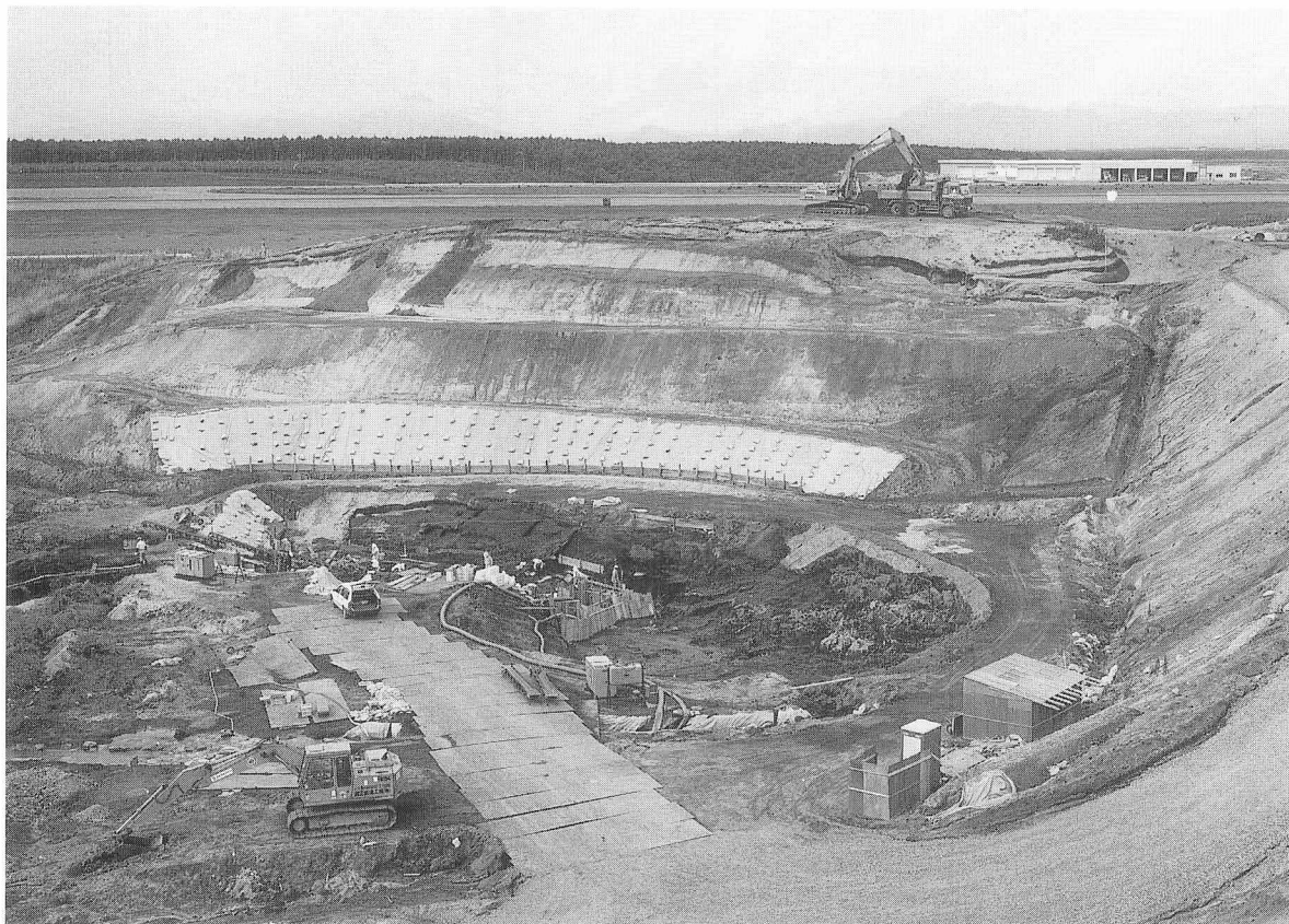
1 調査準備工事状況 E→
