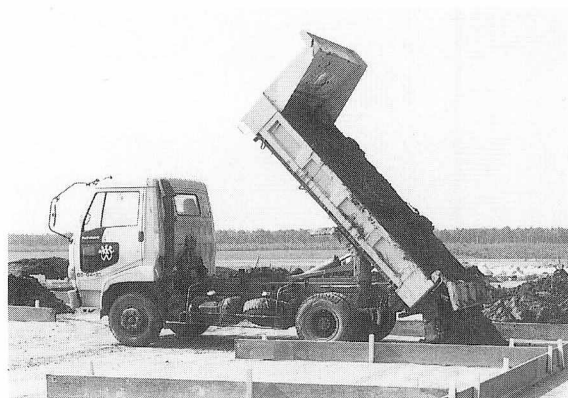
4 B地区作業ヤード包含層搬入状況 NE→
