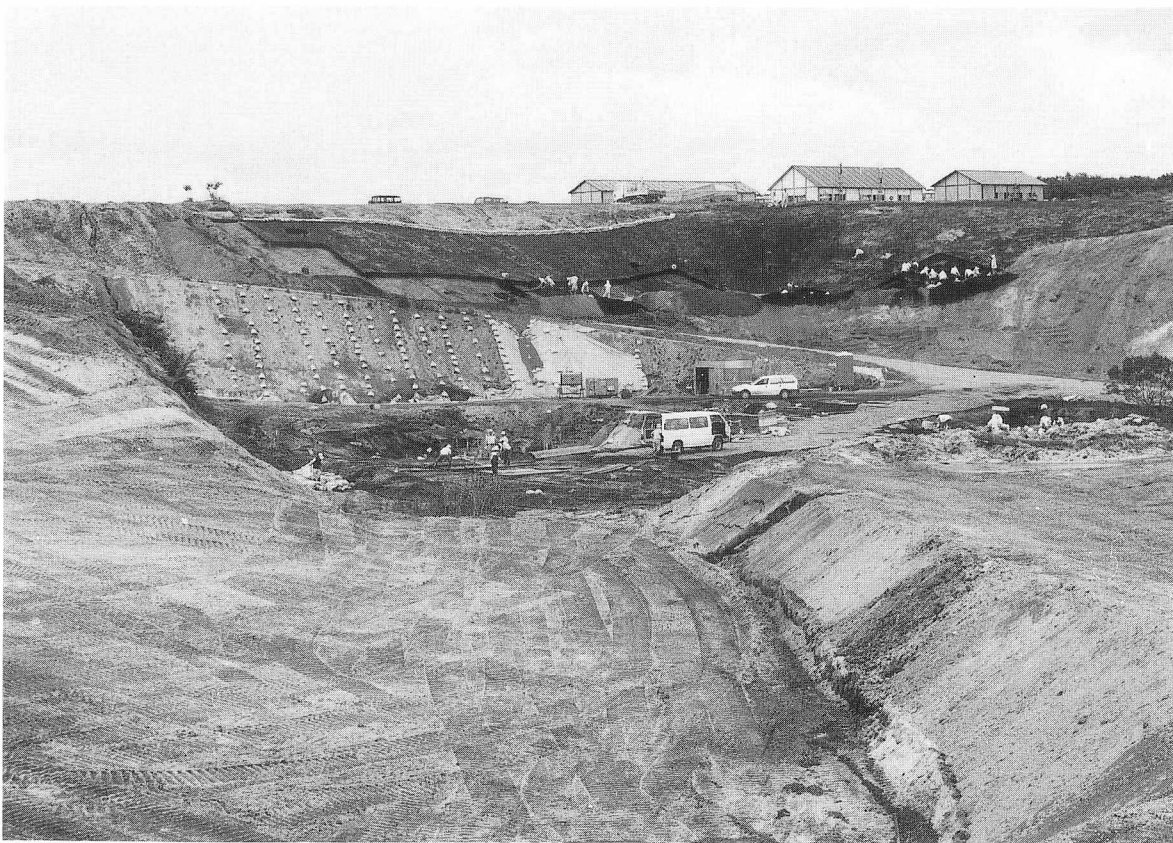
2 B地区埋戻し状況 SW→
