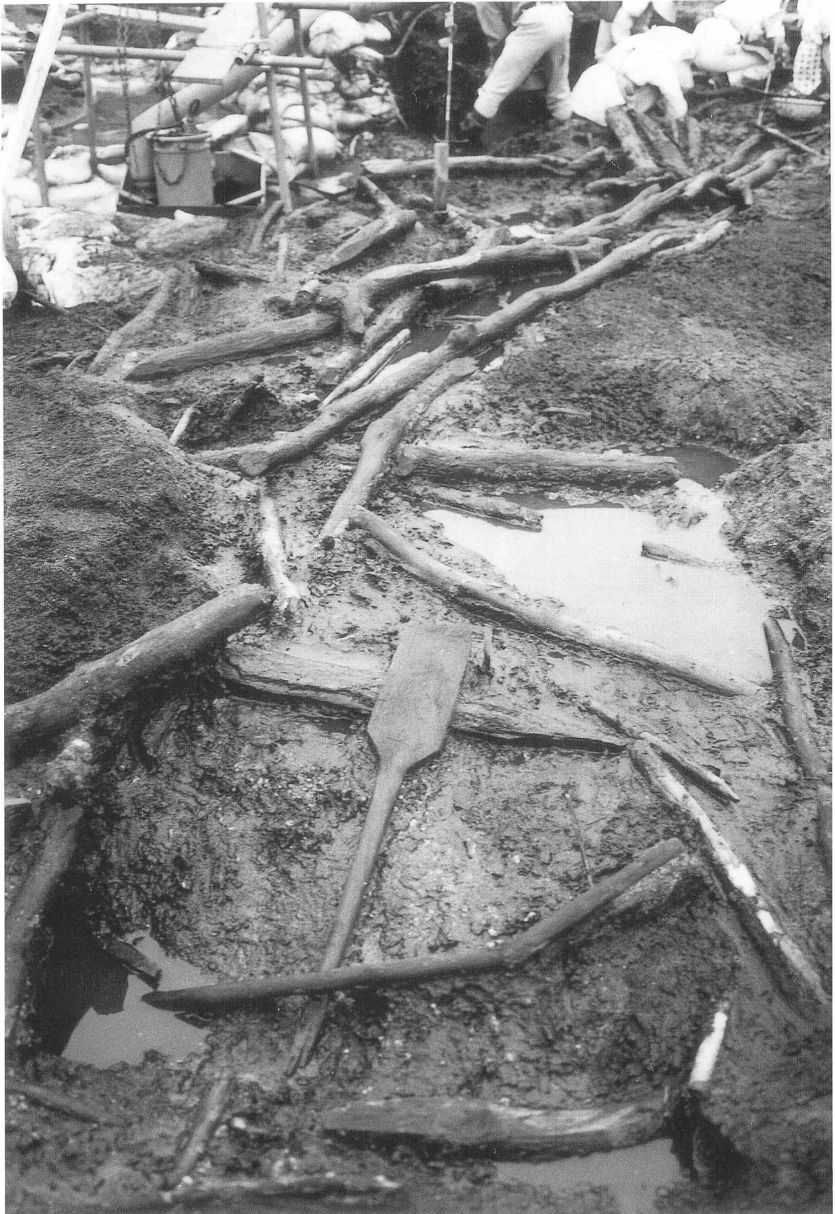
1 A'地区樗・建材出土状況
