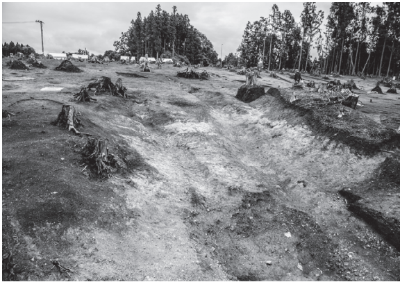
SD04・05 完掘 (S→)
