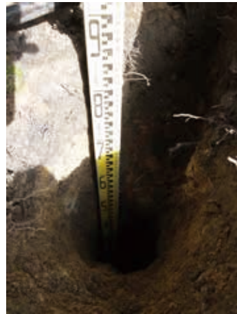
写真22 浸透枡の掘削状況
