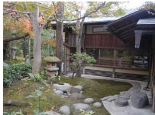
写真39 竣工状況(露地南側)
