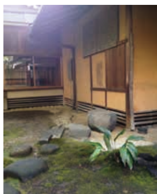
写真30 茶室の北東角の躡口付近
