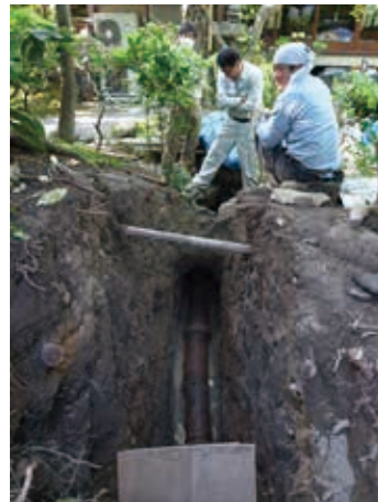
写真15 築山の掘削状況
