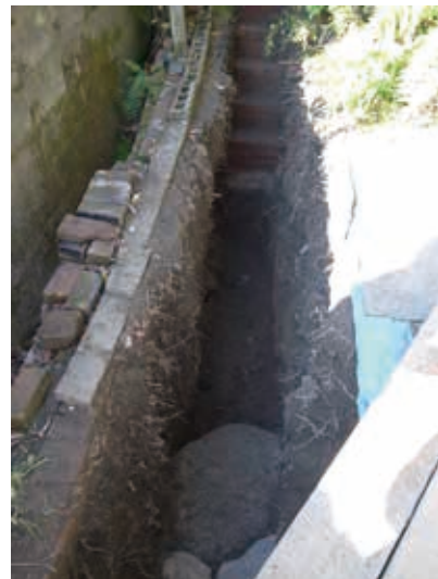
写真18 人孔東方掘削状況
