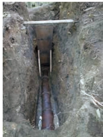
写真16 陶管の敷設状況
