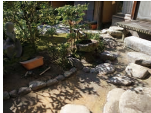
写真24 既設暗渠のレベル調整 （手水鉢の踏石の右手が既設の暗渠枡）
