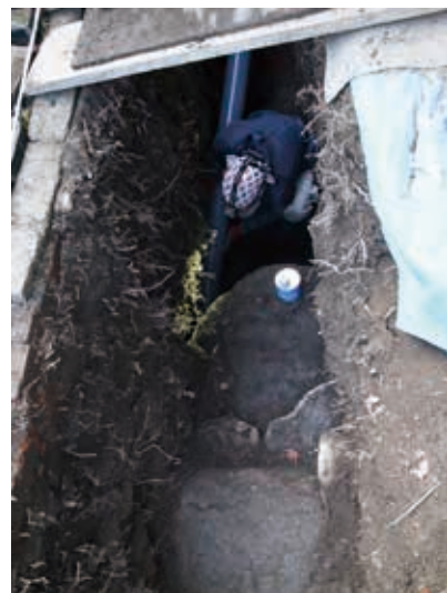
写真19 塩ビ管の挿入作業
