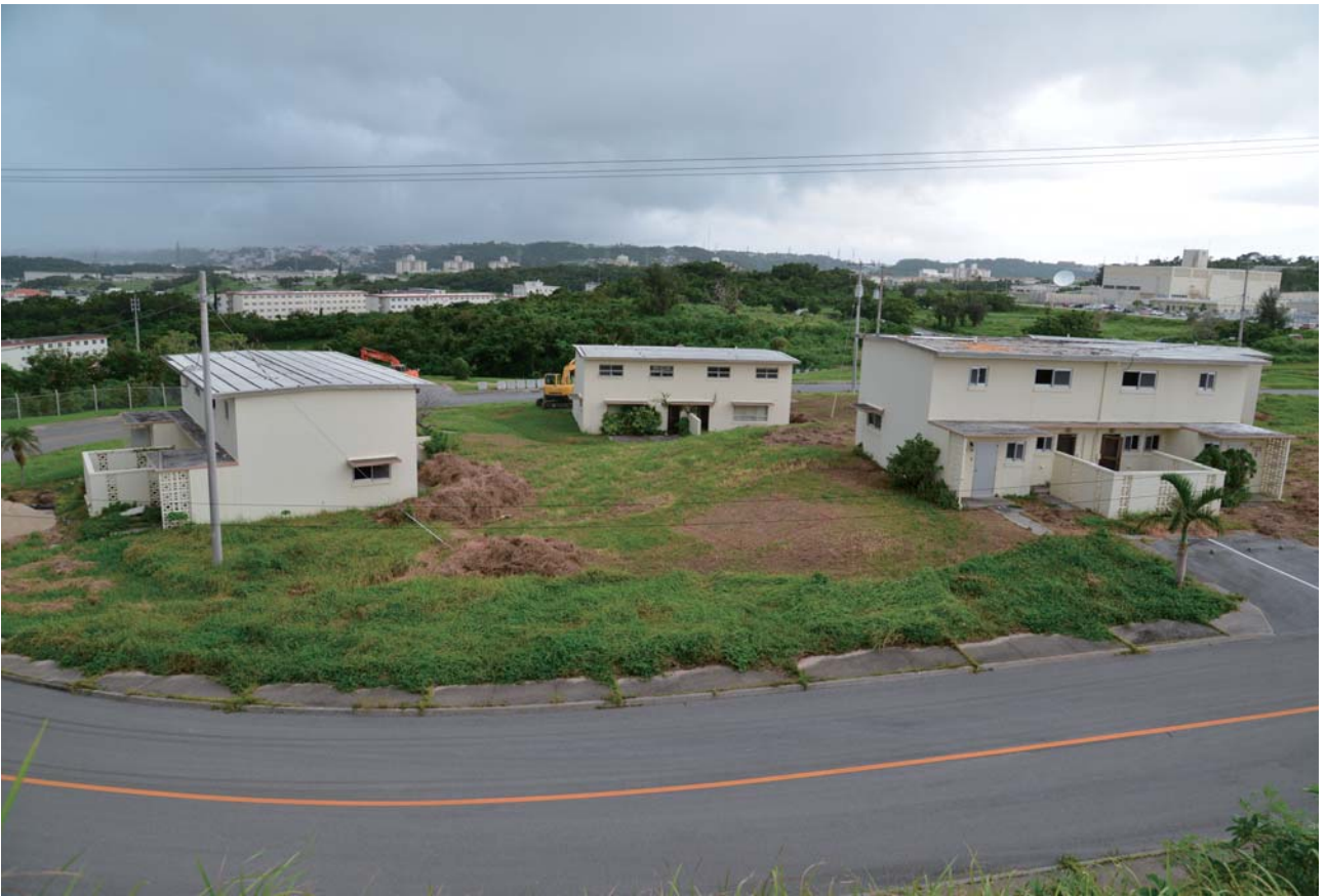
巻頭図版9 ハウジングエリア東側 調査前
