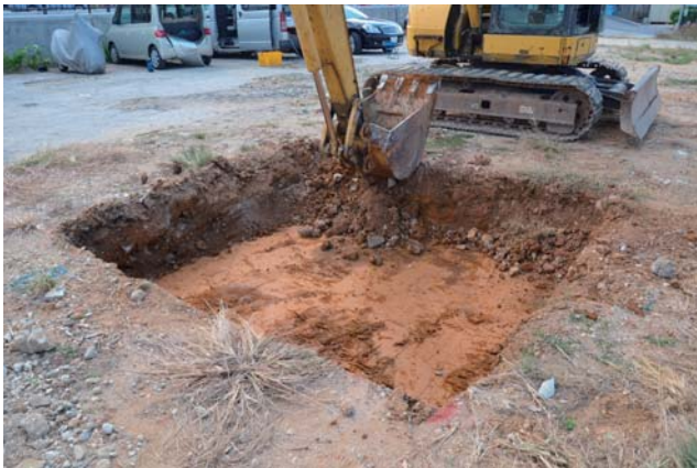
試掘坑No.2 重機掘削
