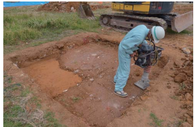
試掘坑No.3 埋戻し(転圧)
