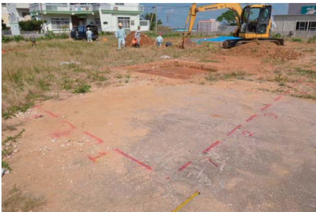
確認坑 設定状況
