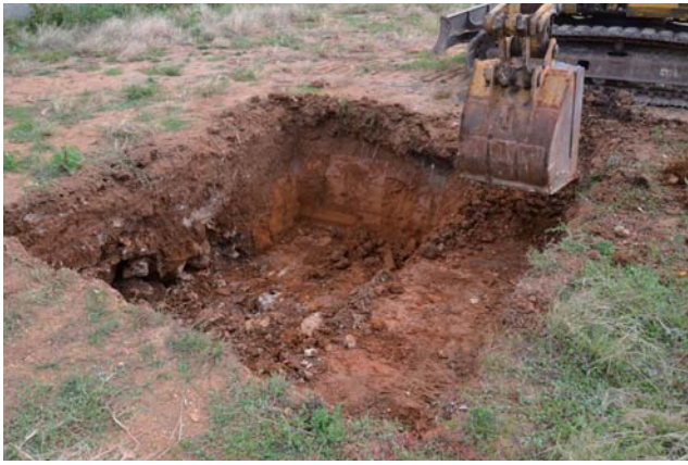
試掘坑No.1 重機掘削
